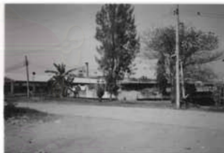
(4) อาคารระบบบำบัดน้ำเสียของพื้นที่
