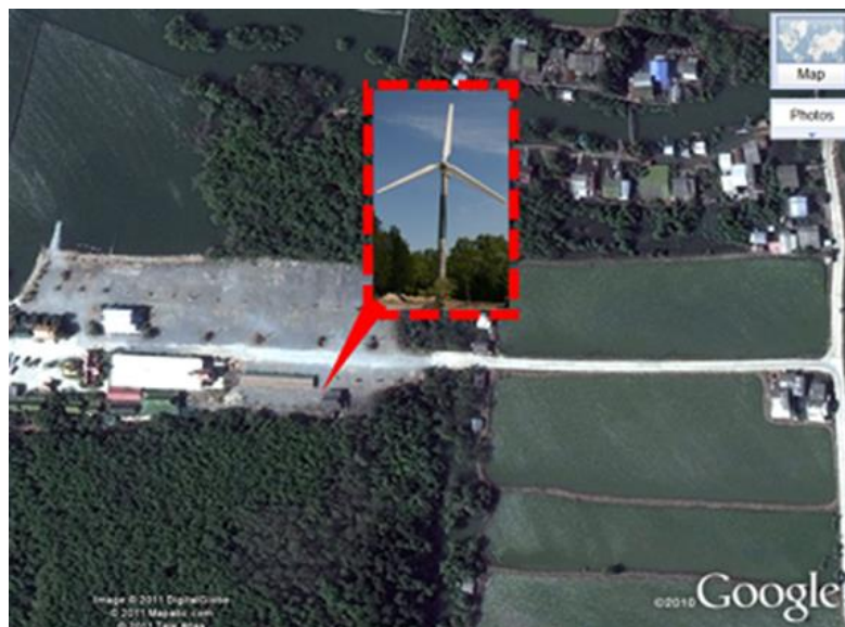
ภาพที่ 3.2 แสดงภาพพื้นที่ในการติดตั้งกังหันลมผลิตไฟฟ้า
