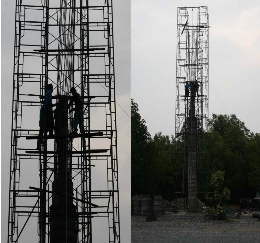
ภาพที่ 4.29 การก่อสร้างเสาแกนหินกลมคอนกรีตเสริมเหล็กสูง 18 เมตร
