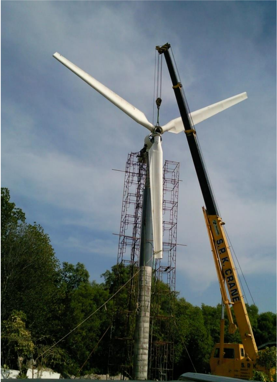
ภาพที่ 4.31 การยกและติดตั้งชุดกังหันลมบนเสาคอนกรีตเสริมเหล็กด้วยรถเครน
