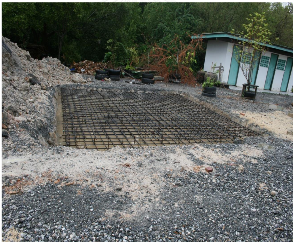
ภาพที่ 4.28 การผูกเหล็กเพื่อหล่อฐานรากขนาด 10 x 10 ตารางเมตร
