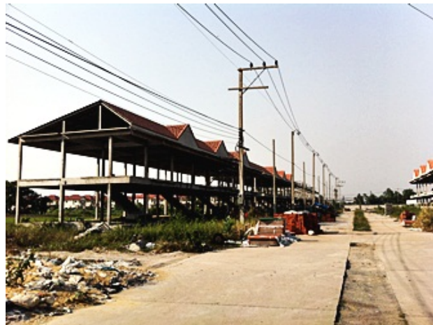
ภาพที่ 4.10 แสดงบริเวณงานก่อสร้างของโครงการถาวรวิลล่า
