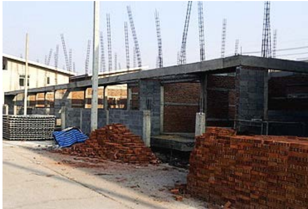
ภาพที่ 4.3 แสดงงานก่อสร้างโครงสร้างชั้นที่ 1 ของโครงการถนนพร
