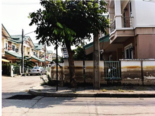
ภาพที่ 4.27 แสดงร่องรอยระดับน้ำที่เข้าท่วมโครงการบ้านสินทรัพย์ที่ปรากฏบนกำแพงบ้าน
