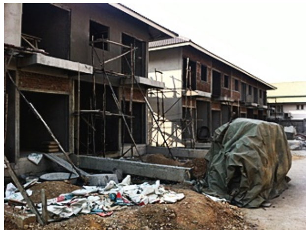
ภาพที่ 4.22 แสดงบริเวณงานก่อสร้างของโครงการภูมิสิริ
