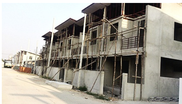
ภาพที่ 4.2 แสดงงานก่อสร้างบ้านของโครงการกนกพร
