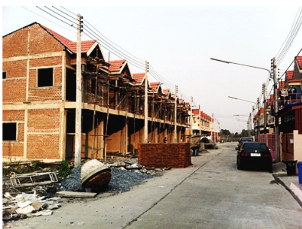
ภาพที่ 4.17 แสดงบริเวณงานก่อสร้างของโครงการบ้านทัศนีย์
