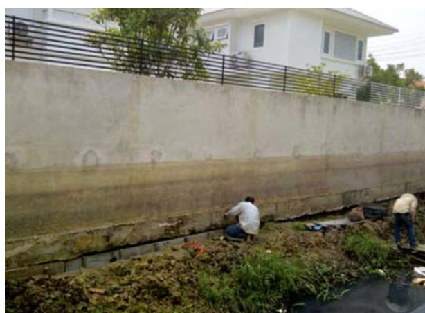
ภาพที่ 2.7 แสดงเข้าแบบและก่อเทคอนกรีตปิดรอยรั้วใต้คาน
