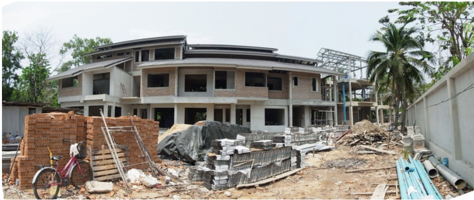
ภาพที่ 5.28 บ้านแถวก่อสร้างแล้วเสร็จ
