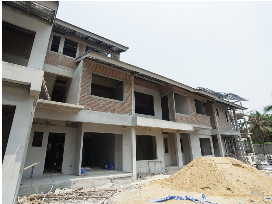
ภาพที่ 5.31 ภาพอาคารก่อสร้างแล้วเสร็จ
