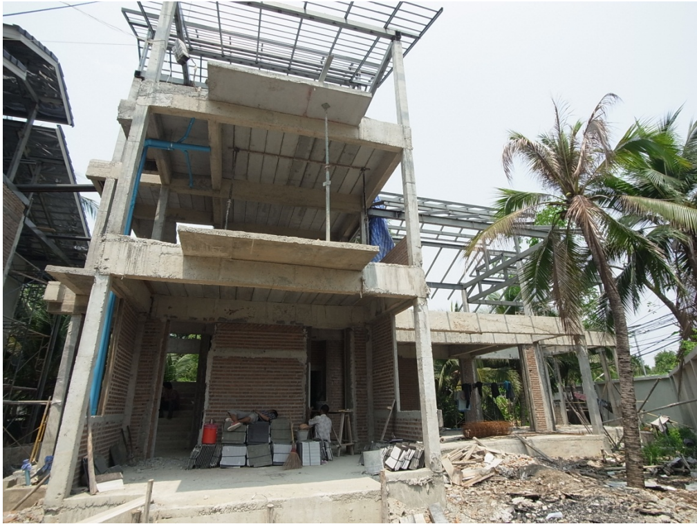
ภาพที่ 5.32 บ้านเดี่ยว กำลังก่อสร้างส่วนหลังคา
