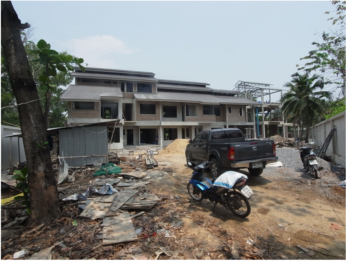
ภาพที่ 5.30 ภาพอาคารก่อสร้างแล้วเสร็จ
