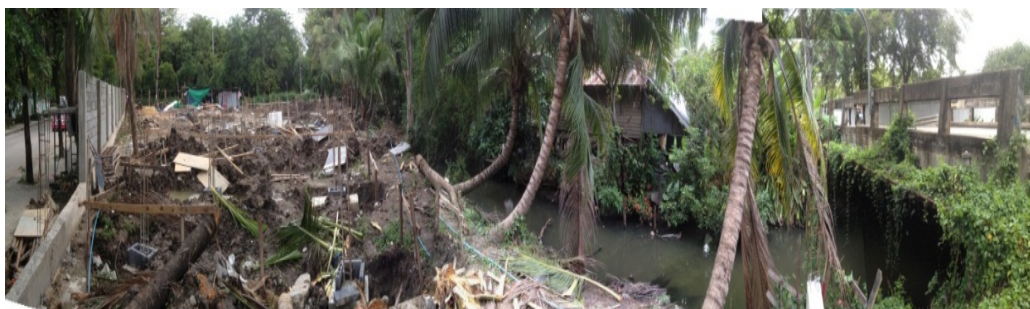
ภาพที่ 5.26 สภาพการก่อสร้างด้านที่ติดคลองหลังโครงการ
