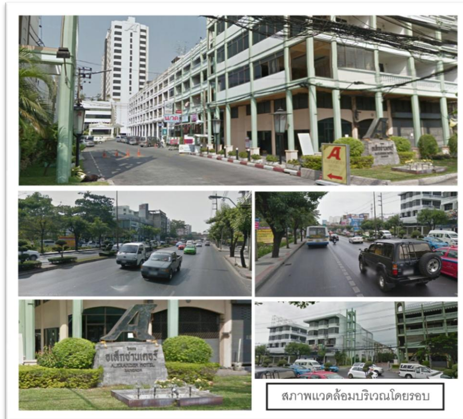
ภาพที่ 4.19 แสดงภายนอกโครงการของของโรงแรมเล็ก 19 ผังบริเวณชั้น 1 แสดงตำแหน่งเส้นทางสัญจรและพื้นที่การใช้งานภายใน
