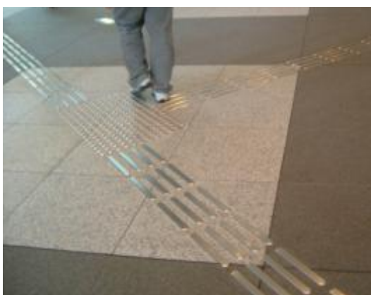
ภาพที่ 2.11 แสดงการติดตั้งแผ่นพื้นสำหรับผู้พิการทางสายตาในสถานที่บริการ
