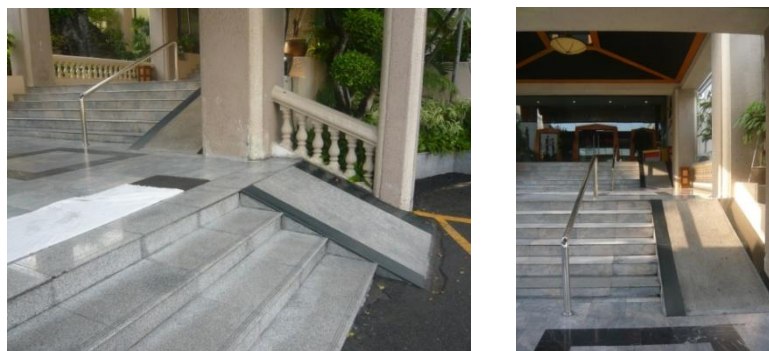
ภาพที่ 5.57 แสดงทางลาด และราวจับของโรงแรมเล็กซานเดอร์ฯ
