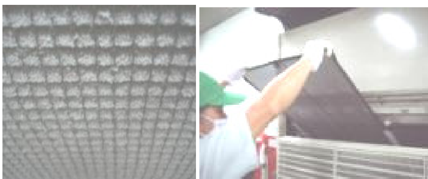
รูปที่ 6-10 ฝุ่นที่ตัวกรองอากาศ (Filter) ด้านล่างของเครื่องปรับอากาศ
