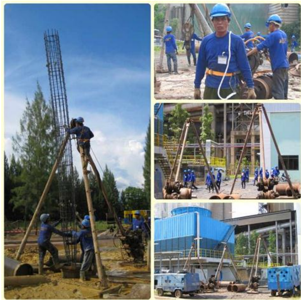
ภาพที่ 1.1 แสดงการตีฝั ง เเจาะเสาเข็มคอนกรีต อาคารทั่วไป
