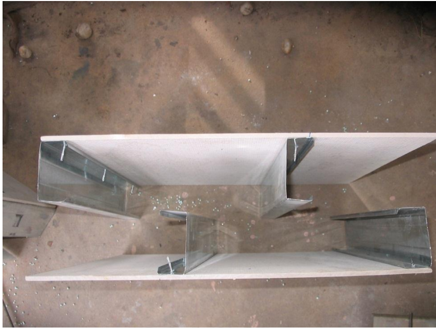
ภาพที่ 4.18 แสดงการวางโครงผนัง ให้วางสลับ เพื่อป้องกันการเกิดสะพานความร้อนเข้าสู่ภายในอาคาร
