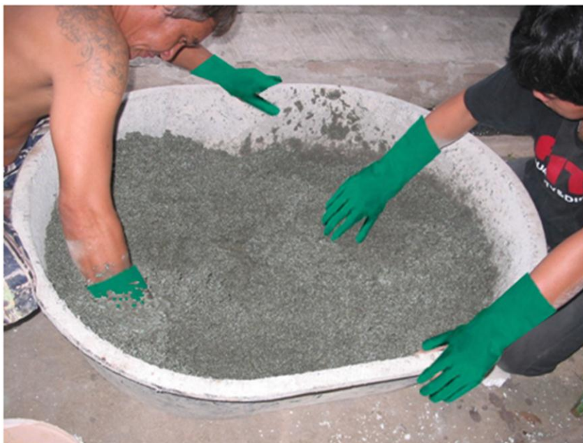
ภาพที่ 4.17 แสดงการผสมโฟม,ซีเมนต์,น้ำ,คลุกเคล้าให้เข้ากันประมาณ 10 นาที จะเห็นว่าอัตราส่วนที่ใช้จะเป็นระบบแห้ง ไม่เปียกเหมือนการผสมปูนทั่วไป
