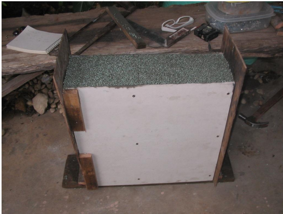
ภาพที่ 4.21 แสดงการทดลองทำผนังประกอบไฟเบอร์บอร์ดภายในกรุโฟมคอนกรีต ( Fiberbord infilwall)
