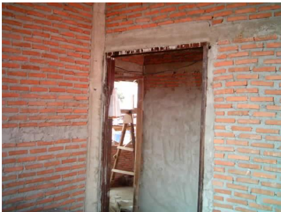
ภาพที่ 1.8 แสดงการก่ออิฐมอญและเอ็น ค.ส.ล. การตั้งวงกบโดยมีเอ็น ค.ส.ล.รอบวงกบ
