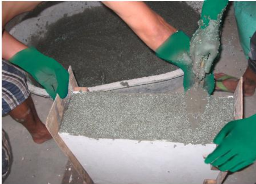
ภาพที่ 4.20 แสดงการเทโฟมคอนกรีตภายในผนังความหนาภายใน 15 เซนติเมตร
