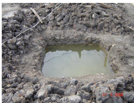
ภาพที่ 1.2 แสดงหลุมฐานรากที่พบปัญหาน้ำใต้ดิน อาคารทั่วไป
