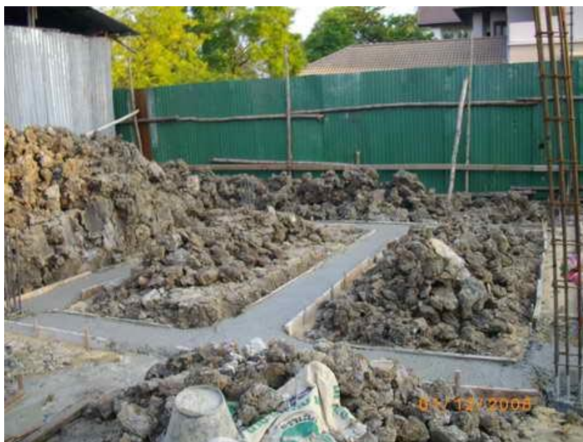
ภาพที่ 1.4 แสดงการปรับห้องคานด้วยคอนกรีต อาคารทั่วไป
