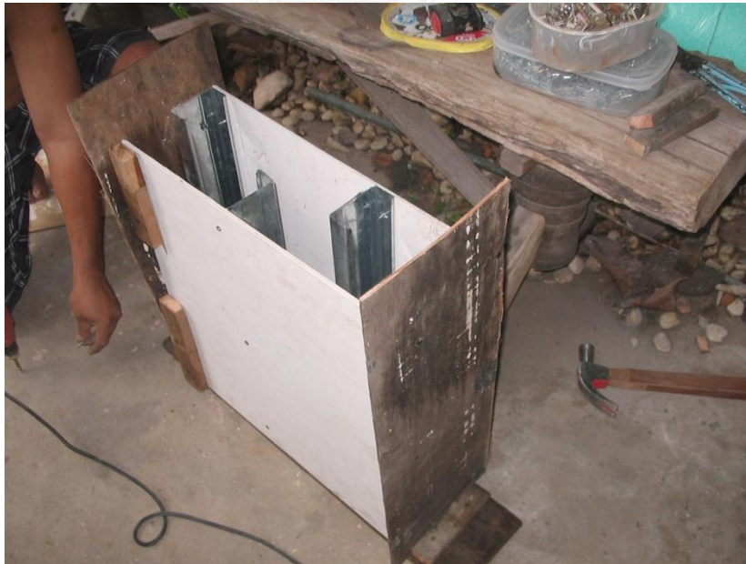
ภาพที่ 4.18 แสดงการวางโครงผนัง ให้วางสลับ เพื่อป้องกันการเกิดสะพานความร้อนเข้าสู่ภายในอาคาร
