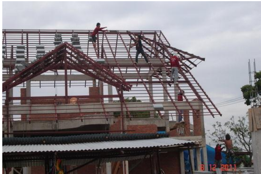
ภาพที่ 1.9 แสดงการติดตั้งโครงหลังคาที่มีการรับน้ำหนักอย่างเป็นขั้นตอน
