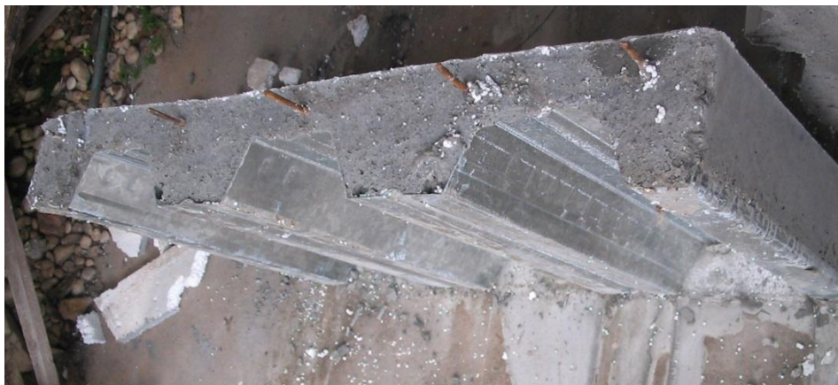
ภาพที่ 4.34 แสดงแผ่นเหล็กกรีดลอนเคลือบ Galvanized หนา 0.08 มิลลิเมตร เมื่อเทคอนกรีตแล้วเสร็จ
