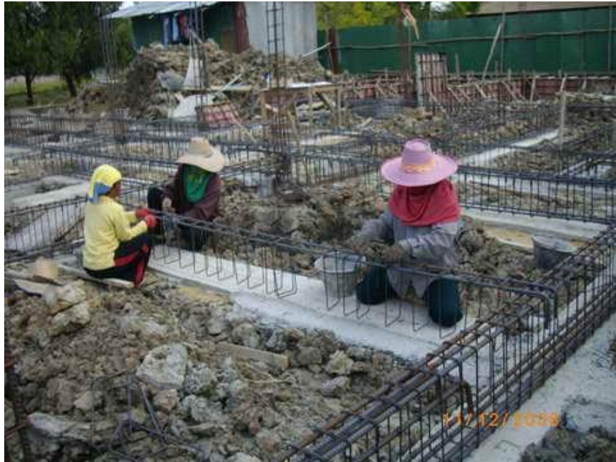
ภาพที่ 1.5 แสดงการผูกเหล็กคานคอดิน อาคารทั่วไป
