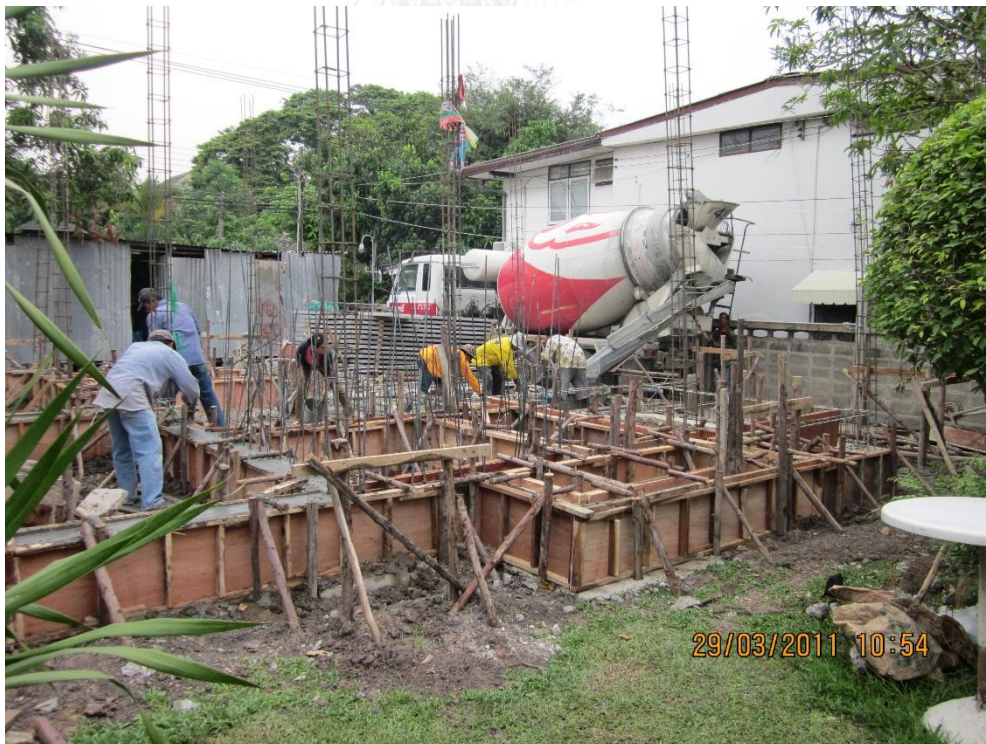
ภาพที่ 1.6 แสดงการเทคอนกรีตคานคอดิน อาคารทั่วไป
