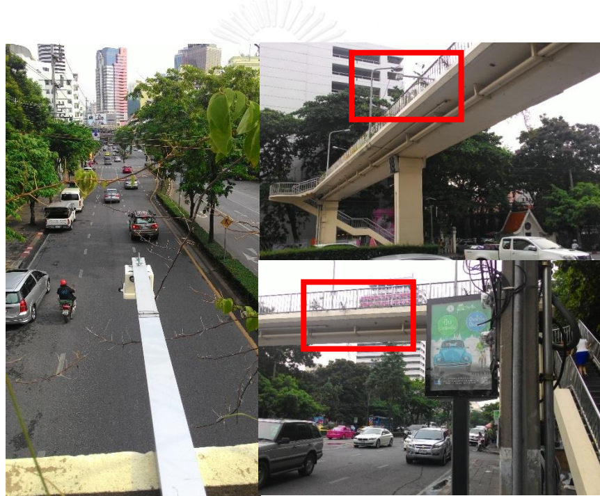
รูปที่ 3.19 : ตำแหน่งในการติดตั้งตัวรับรู้ประเภทบลูทูธบนสะพานลอยบริเวณถนนอังรีดูนังต์
