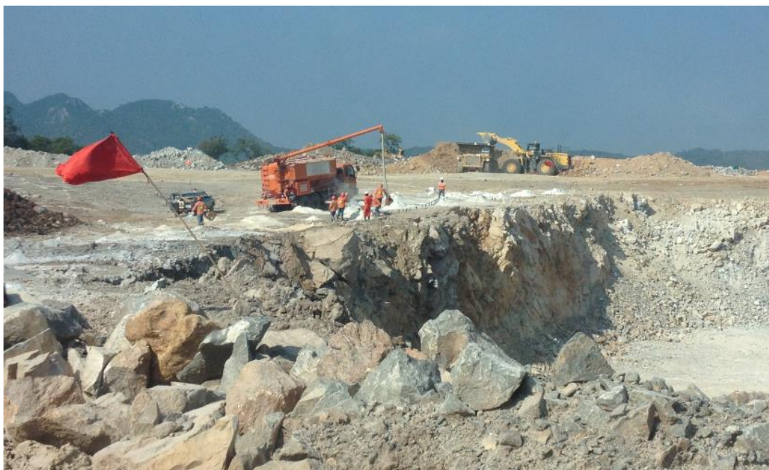
รูปที่ 3-5 แสดงขั้นตอนการเตรียมการระเบิดหิน
