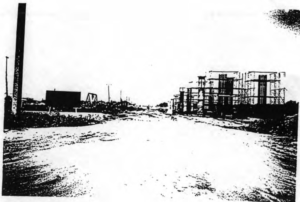
รูปที่ 50 แสดงเส้นทางกรุงเทพฯ-ชลบุรีสายใหม่ที่กำลังก่อสร้าง
