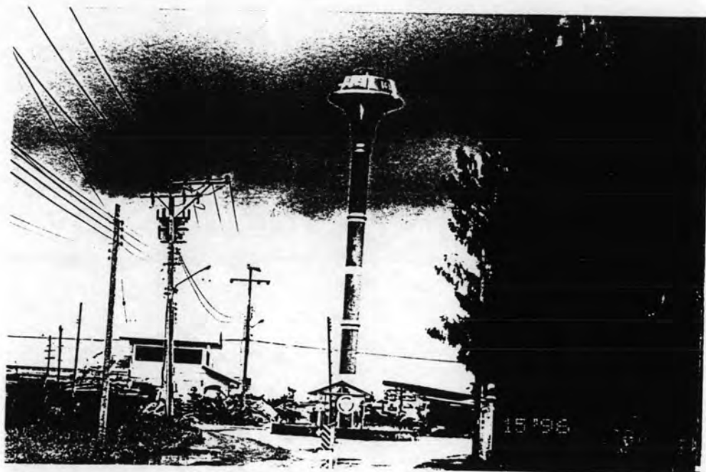
รูปที่ 23 แสดงปลอกสูบน้ำบาดาลแห่งหนึ่งในโครงการหมู่บ้านจัดสรรริมถนนนนทบุรีใหม่
