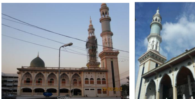
ภาพที่ 49 ภาพมัสยิดอัลยุซรอ ในขณะที่กำลังก่อสร้าง
