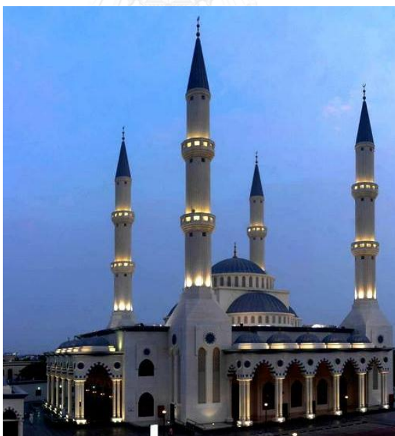
ภาพที่ 143 เทคนิคการให้แสงแบบส่องขึ้น up lighting ที่เสาของชุ่มโค้งของมัสยิดอัล-ฟารูก ดูไบ (ที่มา : http://www.nouran.ae/design-consultancy/projects/farooq-mosque/ : ออนไลน์)
