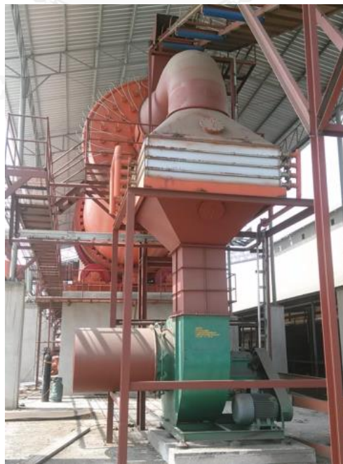
รูปที่ 1.9 เครื่องแลกเปลี่ยนความร้อนแบบใช้อากาศของเครื่องอบแห้งเชื้อเพลิง
