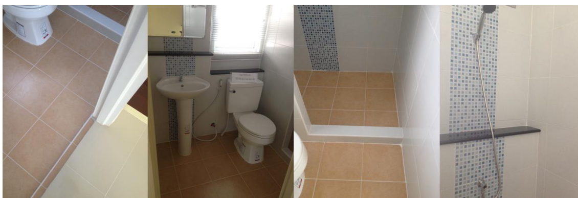
ภาพที่ 4. 32 ห้องน้ำชั้น 2
