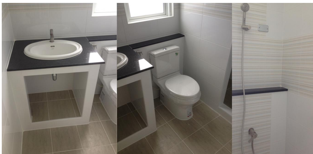
ภาพที่ 4. 14 ห้องน้ำชั้น 1
