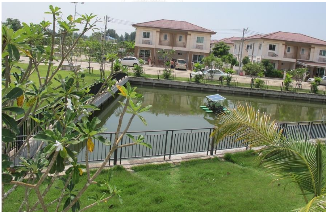
ภาพที่ 4. 44 บ่อบำบัดน้ำเสียและสวนสาธารณะโครงการ
