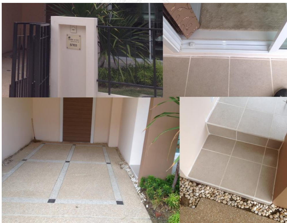
ภาพที่ 4. 20 ประตูรั้ว ที่จอดรถ และเฉลียง
