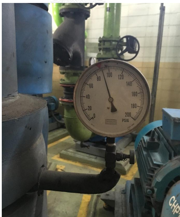
รูปที่ ข.2 การตรวจวัดความดันด้านดูดของเครื่องสูบน้ำเย็น
