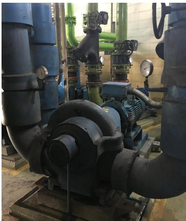
รูปที่ ข.1 เครื่องสูบน้ำเย็นที่ทำการตรวจวัด
