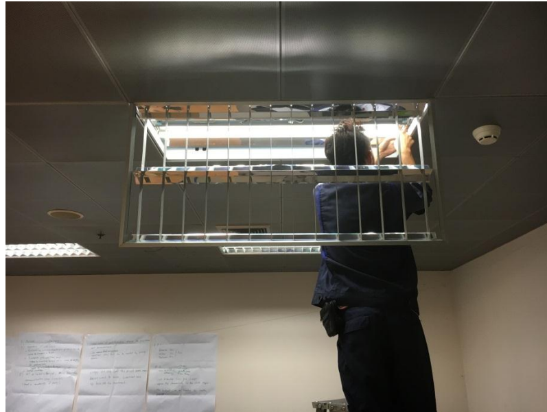
รูปที่ ข.7 การเปลี่ยนหลอดไฟฟ้าจากหลอด Fluorescent เป็นหลอด LED
