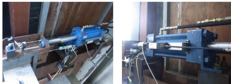
รูปที่ 4.5 การติดตั้งกระบอกไฮดรอลิคเข้ากับคานเพื่อใช้ควบคุมการเคลื่อนที่ของตัวอย่างที่ 1
