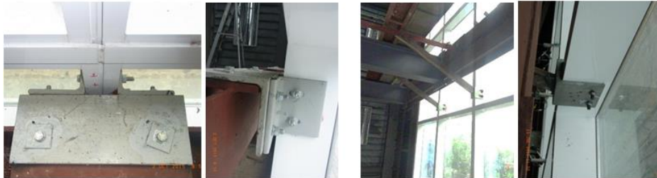
ก) ชิ้นส่วนรองรับติดเข้ากับพื้น (floor bracket) ข) ค้ำยันเพื่อต้านแรงลม
