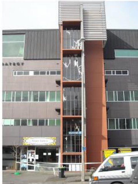
รูปที่ 1.21 การแตกร้าวของกระจกของผนังภายนอกอาคารจากแรงแผ่นดินไหวในอาคาร Strategy Montreal St เมื่อปี 2011 (Mark JS Esslemont, http://wozawanderer.blogspot.com )
