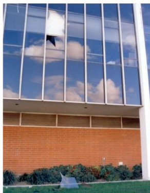
รูปที่ 1.17 การหลุดร่วงของเศษกระจกจากแรงแผ่นดินไหวในประเทศแคลิฟอร์เนีย เมื่อปี 1994 (Photo courtesy of Wiss, Jenney, Elstner Associates, Inc.)
