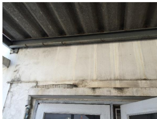
ภาพที่ 4.34 การดัดแปลงหลังคาปกคลุมชั้นดาดฟ้า (ชาย)
