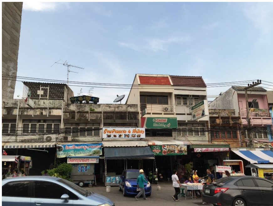
ภาพที่ 4.36 ตึกแถวที่ต่อเติมดาดฟ้าเป็นห้องใช้งานเปรียบเทียบกับตึกที่ไม่ต่อเติม
