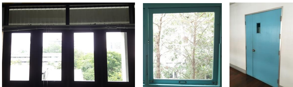
ภาพที่ 4.19 ช่องเปิดรูปแบบต่างๆของอาคาร หน้าต่างอลูมิเนียมบานกระทุ้งและบานเกล็ดกระจกปรับมุมแนวตั้ง (ซ้าย) หน้าต่างไม้บานกระทุ้ง (กลาง) และประตูไม้บานเปิด (ขวา)
