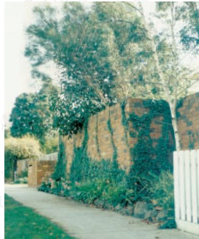
รูปที่ 32 ลักษณะของการใช้พืชพรรณในการช่วยดูดซับเสียงในกำแพงเสียง
