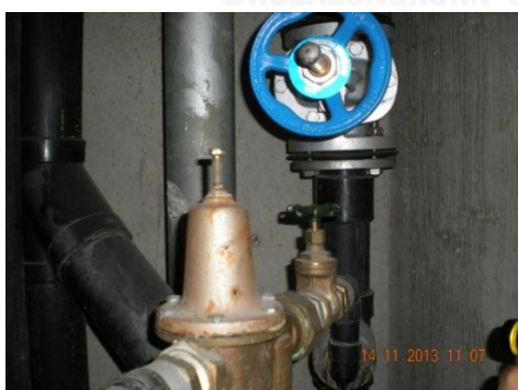
ภาพที่ 12 ภาพแสดงสภาพวาล์วน้ำดี ที่จะต้องมีการเปลี่ยน
