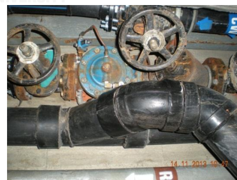
ภาพที่ 12 ภาพแสดงสภาพวาล์วน้ำดี ที่จะต้องมีการเปลี่ยน
