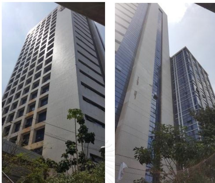
ภาพที่ 4 สภาพเปลือกอาคาร ภปร ฝั่งถนนราชดำริ
