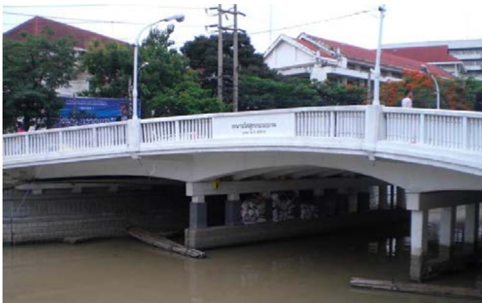
ภาพที่ 4 – 117 สะพานวิศุกรรมนิรมานถ ที่สร้างใหม่ในสมัยรัชกาลปัจจุบัน เป็นสะพานแบบคานยื่น ที่มา : ผู้วิจัย, มกราคม 2555
