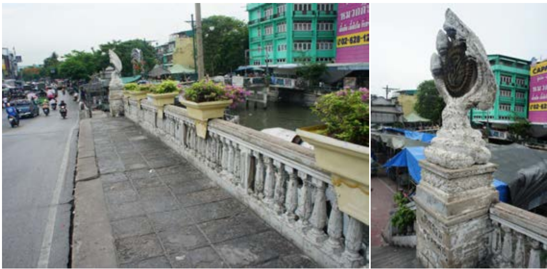
ภาพที่ 4 – 55 สะพานร้อยปี (สะพานเจริญราษฎร์ 32) ในปัจจุบัน ที่มา : ผู้วิจัย, มีนาคม 2555
