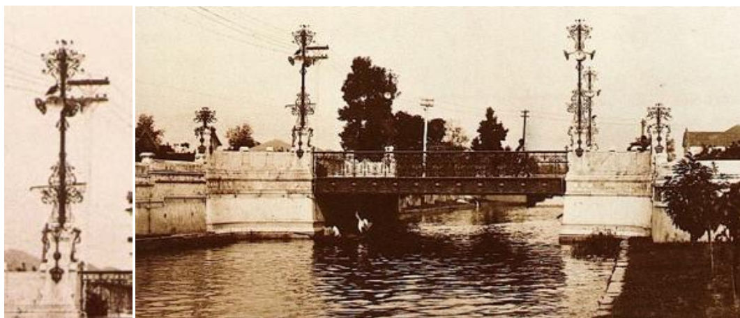
ภาพที่ 4 – 106 สะพานผ่านพิภพลีลา สร้างเมื่อ พ.ศ. 2447 ราวสะพานศิลปะแบบอาร์ต นูโว (Art Nouveau) รูปแบบเสาและเชิงสะพานแบบ นีโอคลาสสิก (Neo – Classic)
