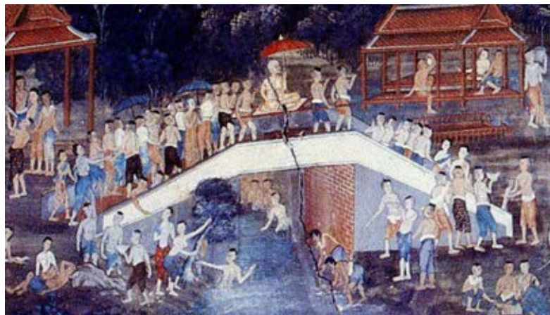
ภาพที่ 2- 4 สะพานก่ออิฐถือปูน จากจิตรกรรมฝาผนังสมัยรัชกาลที่ 3 ในพระอุโบสถวัดมหาสมณาราม อ.เมือง จ.เพชรบุรี. ที่มา : จิตรกรรมกรุงรัตนโกสินทร์.
