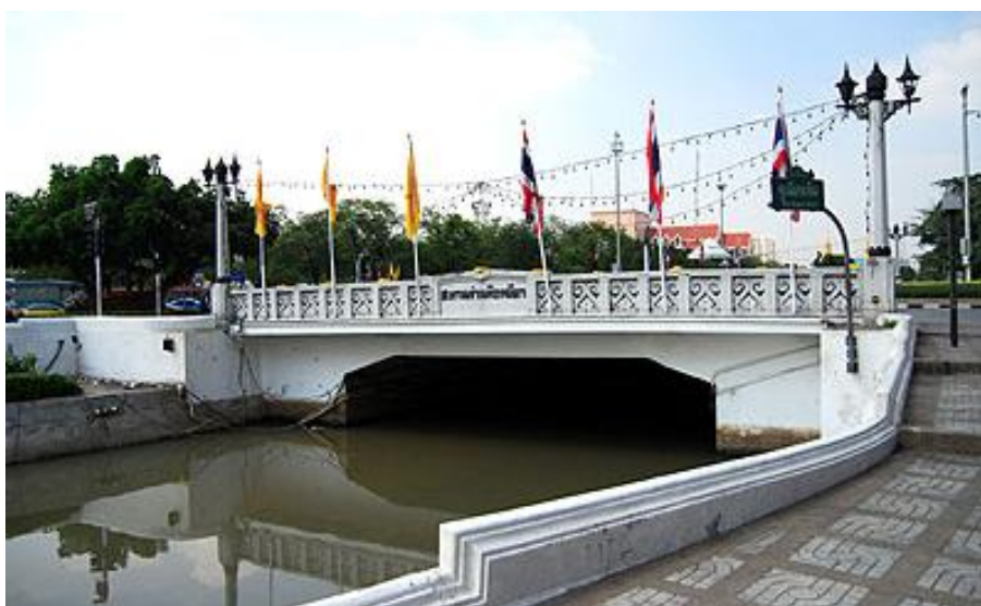
ภาพที่ 4 - 115 สะพานผ่านพิภพลีลาในปัจจุบัน รูปแบบเป็นสะพานแบบคาน ที่มา : http://www.thainewsland.com
