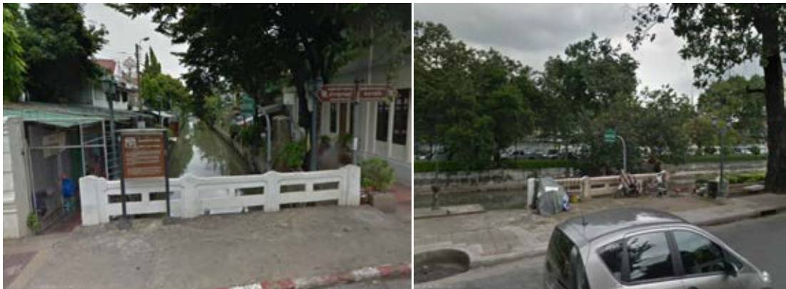
ภาพที่ 4 – 34 สะพานเหล็กริมวัดราชบพิธในปัจจุบัน ที่มา : ผู้วิจัย, ธันวาคม 2554
