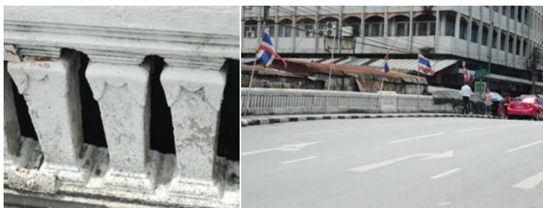
ภาพที่ 4 – 44 สะพานกาญจนาภิเษก ในปัจจุบัน ที่มา : ผู้วิจัย, ธันวาคม 2554
