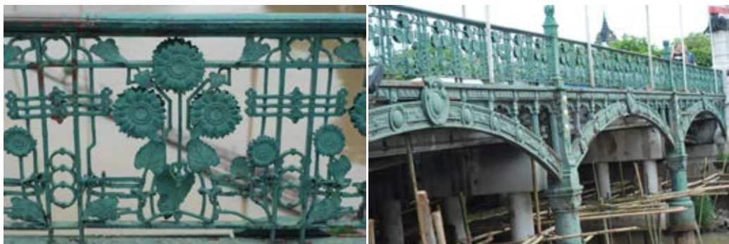
ภาพที่ 4 – 29 สะพานผ่านฟ้าลีลาศในปัจจุบัน ที่มา : ผู้วิจัย, ธันวาคม 2554
