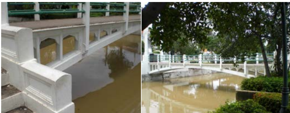
ภาพที่ 4 – 15 สะพานหกถนนสรายุรมย์ (สะพานปีกุน) ในปัจจุบัน ที่มา : ผู้วิจัย, ธันวาคม 2554
