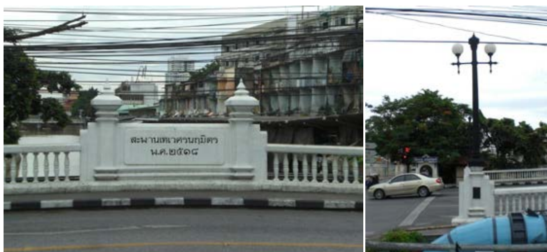
ภาพที่ 4 – 47 สะพานเทพนครนฤมิตร ในปัจจุบัน ที่มา : ผู้วิจัย, ธันวาคม 2554
