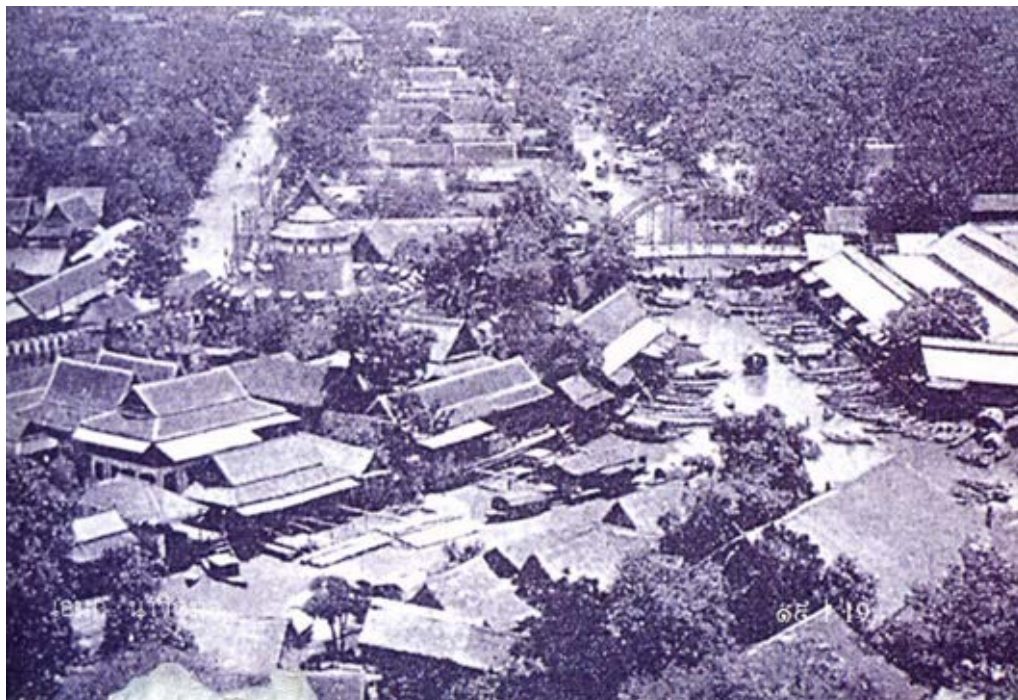
ภาพที่ 5 - 4 สะพานผ่านฟ้าลีลาศ โครงสร้างเหล็กโค้งบน ในสมัยรัชกาลที่ 5 ที่มา : อเนก นาวิกมูล
