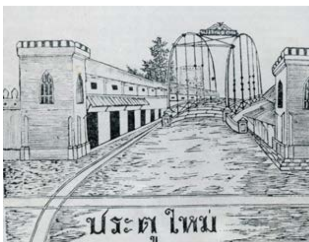
ภาพที่ 4 – 22 ภาพวาดสะพานนรรัตนสถาน เป็นสะพานโค้งเหล็กโค้งบน ที่มา : ศิริชัย นฤมิตรเรขการ, สะพานเก่ากรุงเทพฯ, หน้า 32
