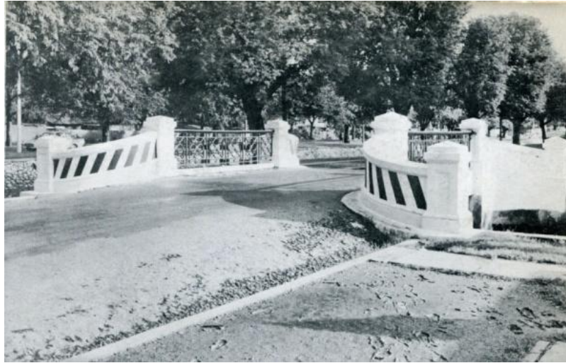
ภาพที่ 4 – 70 สะพานโศภาค เมื่อ พ.ศ. 2520 ที่มา : ศิริชัย นฤมิตรเรขการ, สะพานเก่ากรุงเทพฯ, หน้า 97
