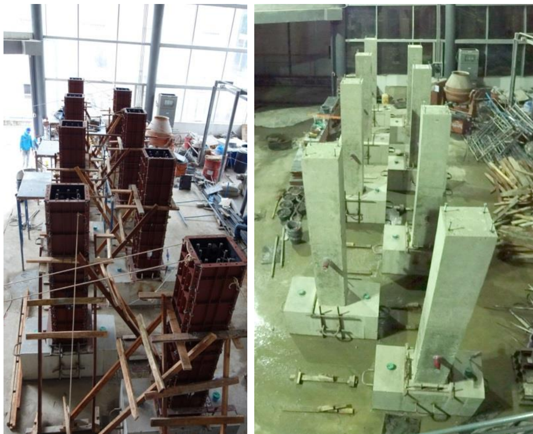
รูปที่ 4.14 การตั้งแบบหล่อคอนกรีตของเสา (ซ้าย) และเมื่อถอดแบบหล่อคอนกรีต (ขวา)
