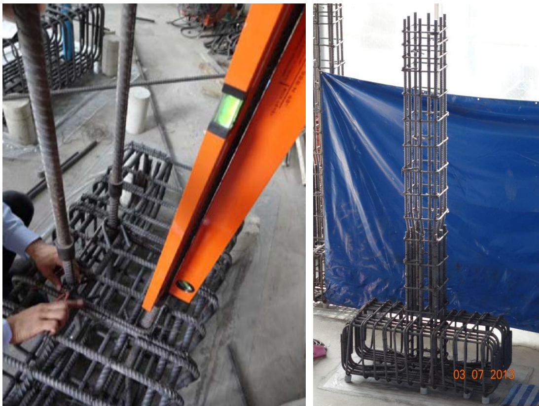
รูปที่ 4.7 การตั้งเสาโดยผูกเหล็กยื่นกับเหล็กของฐานโดยมีการตรวจเช็คระยะห่างระหว่างเหล็กยื่นจุดศูนย์กลางเสาและระดับแนวตั้ง
