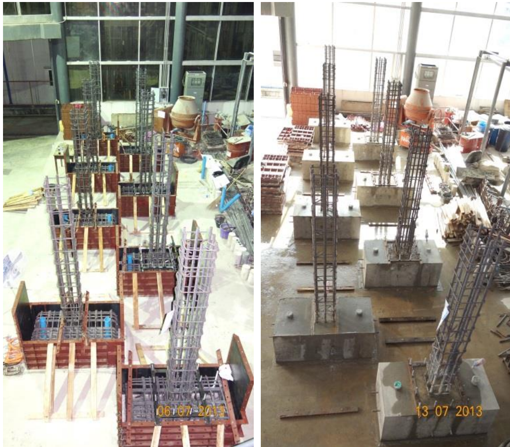
รูปที่ 4.12 การตั้งแบบหล่อคอนกรีตของฐานราก (ซ้าย) และเมื่อถอดแบบหล่อคอนกรีต (ขวา)
