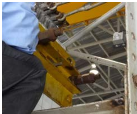
รูปที่ 4.22 การติดตั้งเครื่องวัดการเคลื่อนที่แบบไฟฟ้าที่ใช้วัดการเคลื่อนที่ของฐานราก (ซ้าย) วัดการเคลื่อนที่ของผนังรับแรง (ขวา) และวัดการเคลื่อนที่ของหัวเสา (ล่าง)
