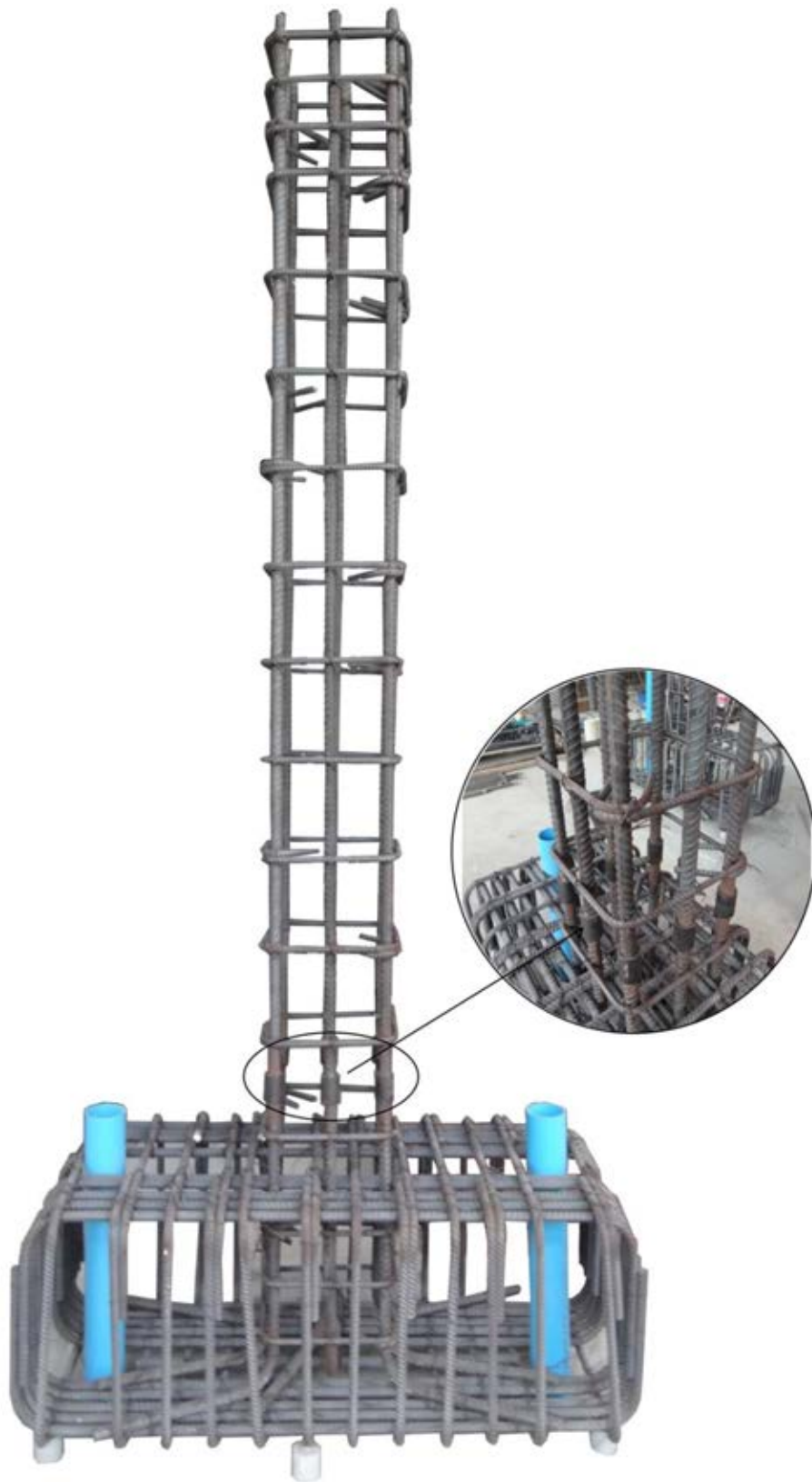
รูปที่ 4.9 ตัวอย่างเสา C-MS-100 เมื่อทำการประกอบเหล็กเสริมเสร็จสิ้น
