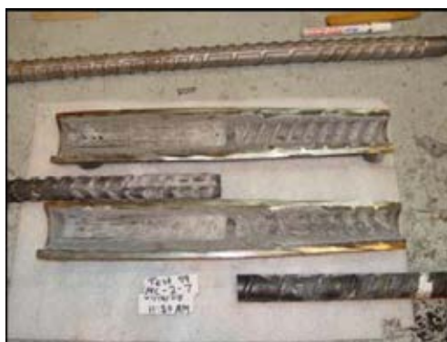
รูปที่ 2.7 การวิบัติในลักษณะที่เหล็กเสริมหลุดออกจอตั้วข้อต่อเชิงกลประเภท Grouted Sleeve Coupler (Rowell และ Grey,2009)
