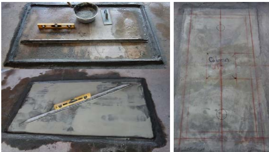
รูปที่ 4.5 การปรับระดับพื้นให้ไม่มีความลาดเอียง (ซ้าย) ตีเส้นเพื่อแสดงตำแหน่งต่างๆ (ขวา)
