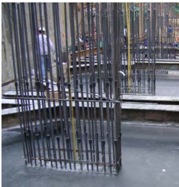
รูปที่ 1.3 การต่อเหล็กเสริมตามยาวด้วยข้อต่อเชิงกลบริเวณจุดหมุนพลาสติก
