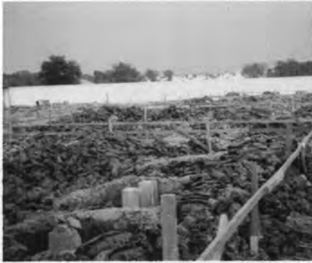
ภาพที่ 4.23 แสดงการติดตั้งงานฐานรากและวางแนวระดับคานคอดิน
