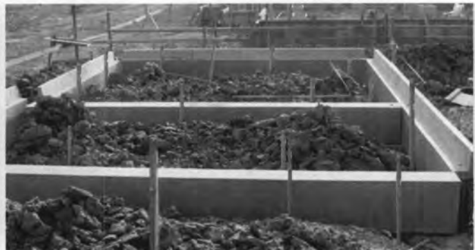
ภาพที่ 4.24 แสดงการติดตั้งคานคอดิน
