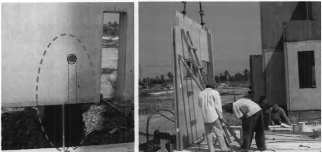
ภาพที่ 4.27 แสดงการติดตั้งผนังคอนกรีตสำเร็จรูปชั้นล่าง
