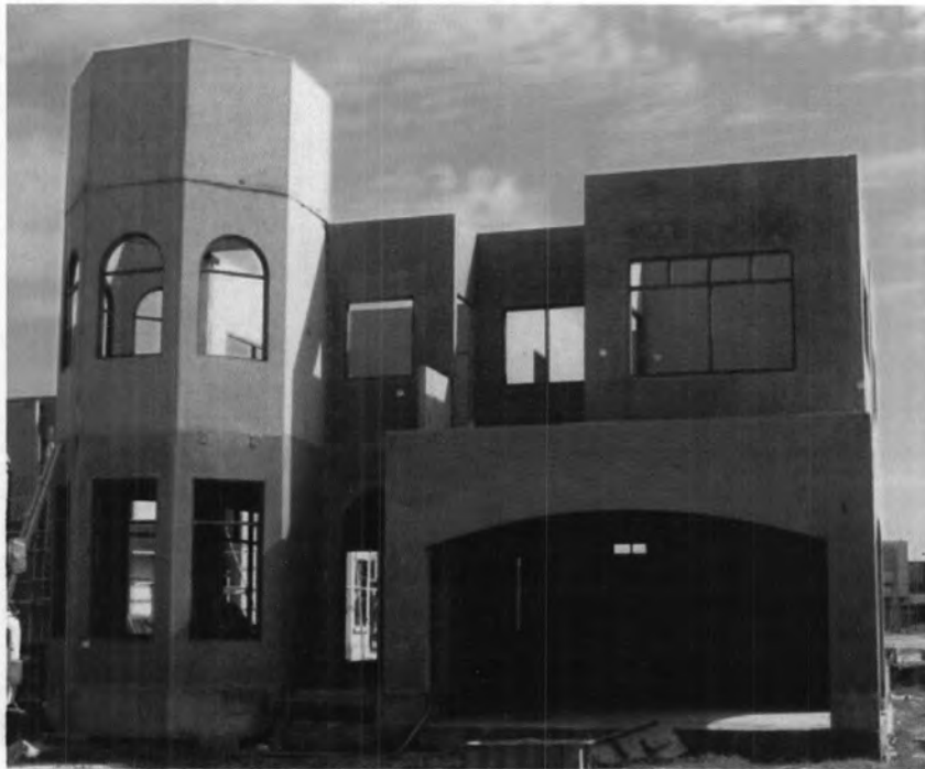
ภาพที่ 4.32 แสดงลักษณะของบ้านที่ประกอบขึ้นส่วนสำเร็จรูป เสร็จทั้งสองชั้น 5.งานประสานรอยต่อขึ้นส่วนคอนกรีตสำเร็จรูป (Joint Connection) แบ่งออกเป็น
