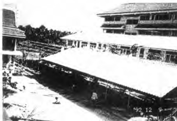
ภาพที่ 4.2 อาคารน็อคดาวน์ที่สร้างขึ้นเพิ่มเติมภายในสำนักปฏิบัติธรรม
