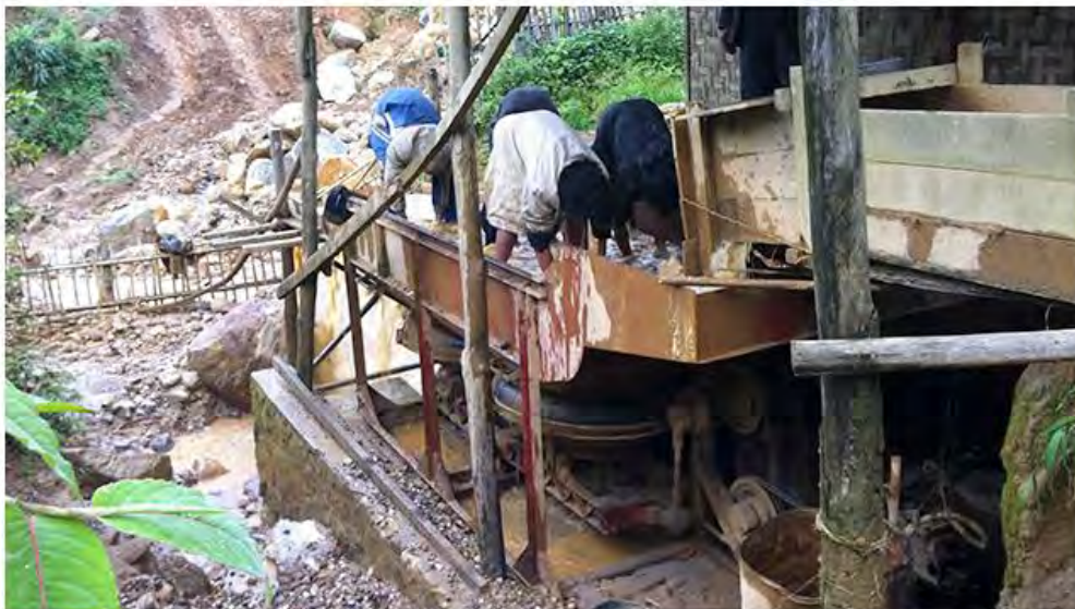
รูปที่ 2.10 ภาพ washing plant (ภาพถ่ายโดย Daniel Nyfeler)
