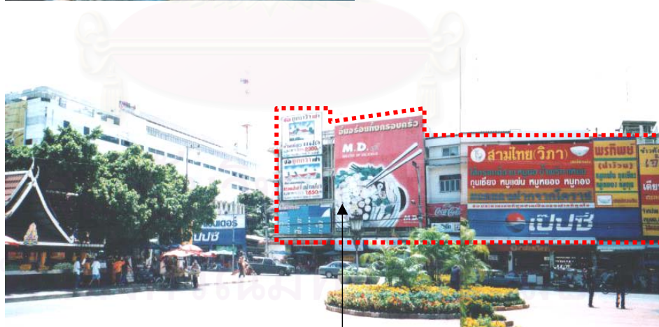
ป้ายที่ติดตั้งหน้าอาคารควบคุมการติดตั้งไม่ให้สูงเกินระดับพื้นที่ชั้นสามของอาคาร
