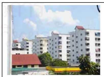
รูปภาพ C แสดงสภาพอาคาร ถ่ายบนจากสะพานลอย
