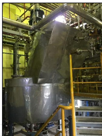
รูปที่ 3.2 ถังตกตะกอน
