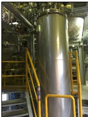
รูปที่ 3.3 ถังเก็บน้ำล้น
