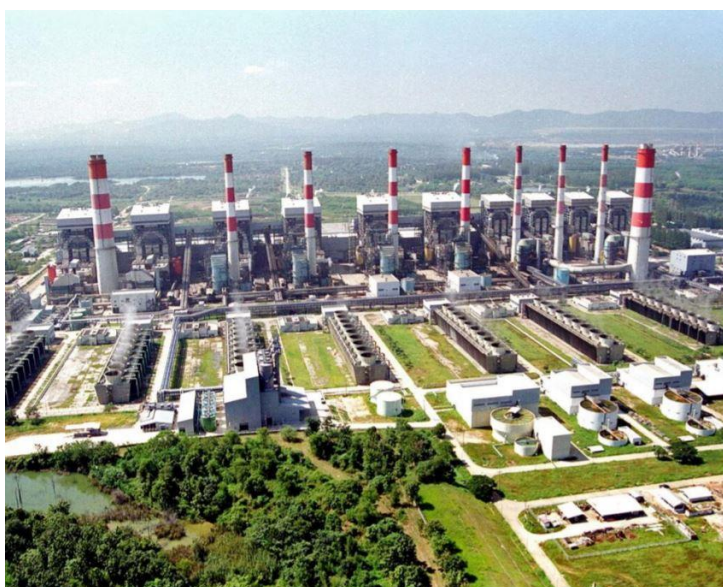
รูปที่ 2-4: โรงไฟฟ้าแม่เมาะ
