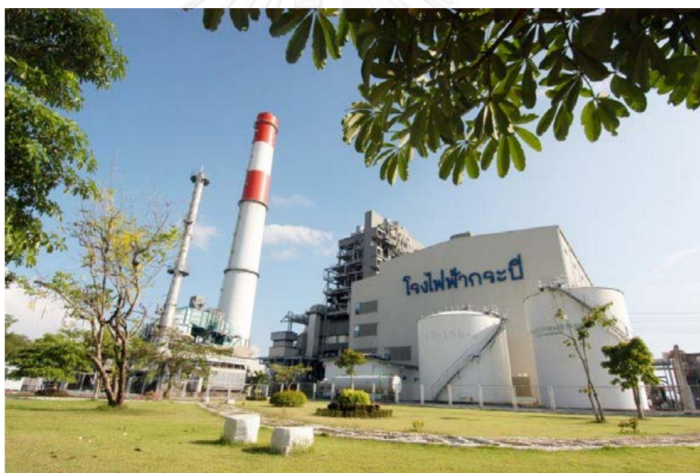
รูปที่ 2-3: โรงไฟฟ้ากระบี่
