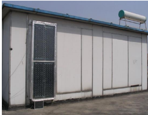
ภาพที่ 22 ห้องทดลองแบบที่ติดตั้งพัดลมระบายอากาศพลังงานแสงอาทิตย์ (ซ้าย) และห้องทดลองที่ไม่ติดตั้ง (ขวา) (Jie, Hua, Gang et al., 2006)
