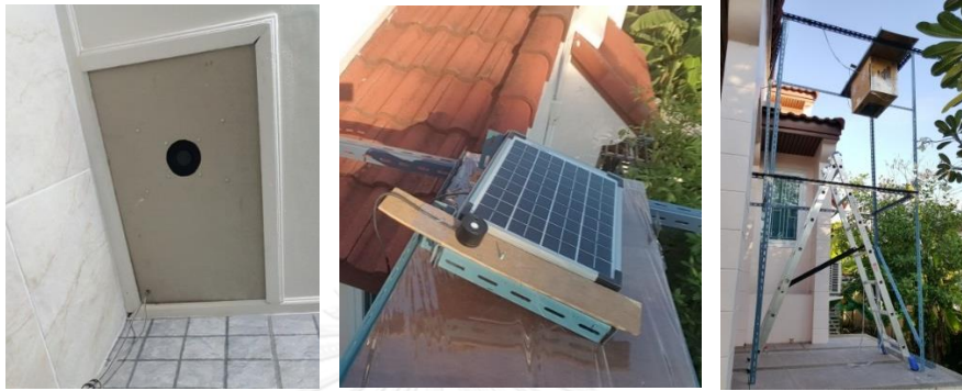
ภาพที่ 28 การติดตั้งอุปกรณ์ทำการทดลอง
