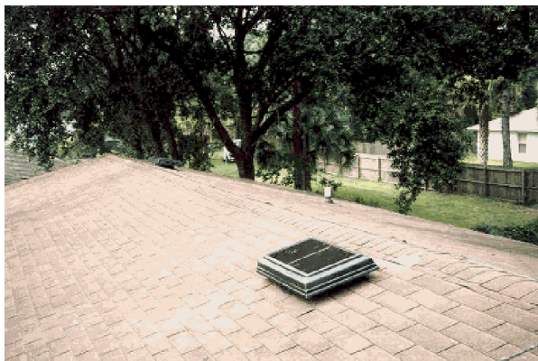
ภาพที่ 24 พัดลมระบายอากาศติดตั้งหลังคาพลังงานแสงอาทิตย์ (Parker and Sherwin, 2000)
