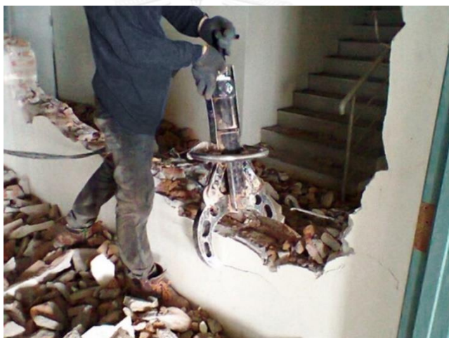
รูปที่ 2.24 การสวมอุปกรณ์ป้องกันพร้อมเครื่องมือที่ใช้ทำการรื้อถอน
