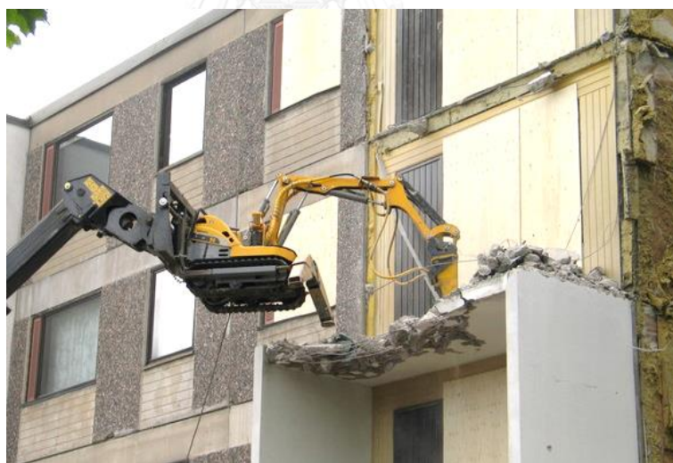
รูปที่ 2.20 การรื้อถอนอาคารโดยเครื่องจักร
