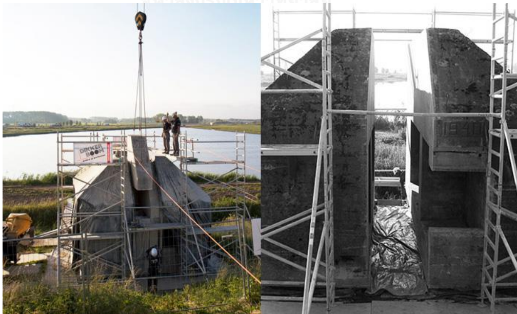
รูปที่ 2.12 การเจาะรื้อแท่นบังเกอร์ โครงการ Bunker 599
