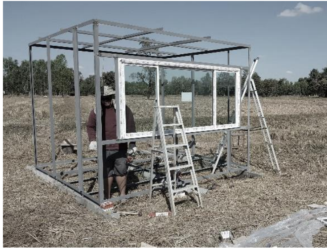
ภาพที่ 13 การก่อสร้างโครงสร้างของห้องทดลอง
