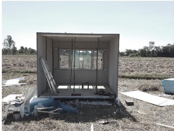
ภาพที่ 14 การติดตั้งวัสดุผิวและฉนวนกันความร้อนของห้องทดลอง
