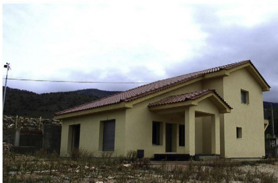
ภาพที่ 8 อาคารที่ใช้ทำการทดลองประกอบผนังวัสดุเปลี่ยนสถานะ (ที่มา: Mandilaras et al., 2013)
