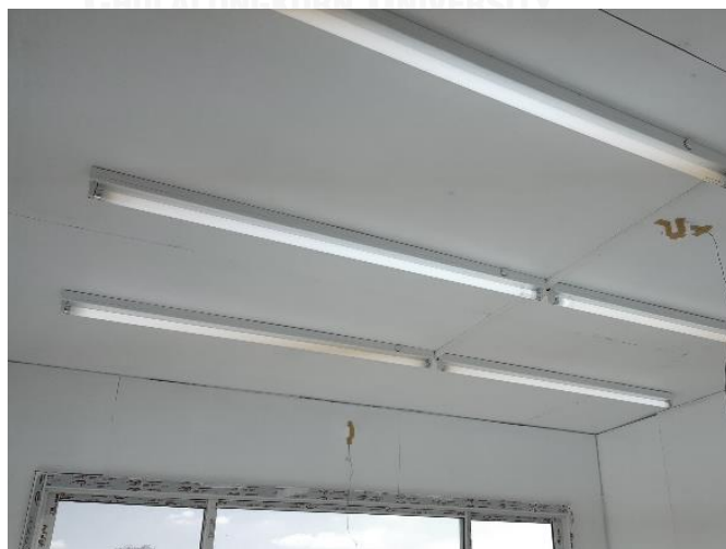
ภาพที่ 15 การติดตั้งวัสดุภายในและหลอดไฟ
