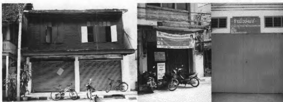
รูปที่ 4.45 อาคารเก่าที่ไม่มีการใช้งานเป็นอาคารที่มีอายุการใช้งานเกินกว่า 50 ปีขึ้นไป (ที่มา : จากการสำรวจของผู้วิจัย 2551)
