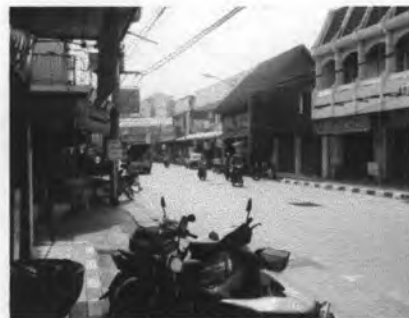
รูปที่ 4.13 สภาพถนนเจริญเมืองปัจจุบัน(2551)
