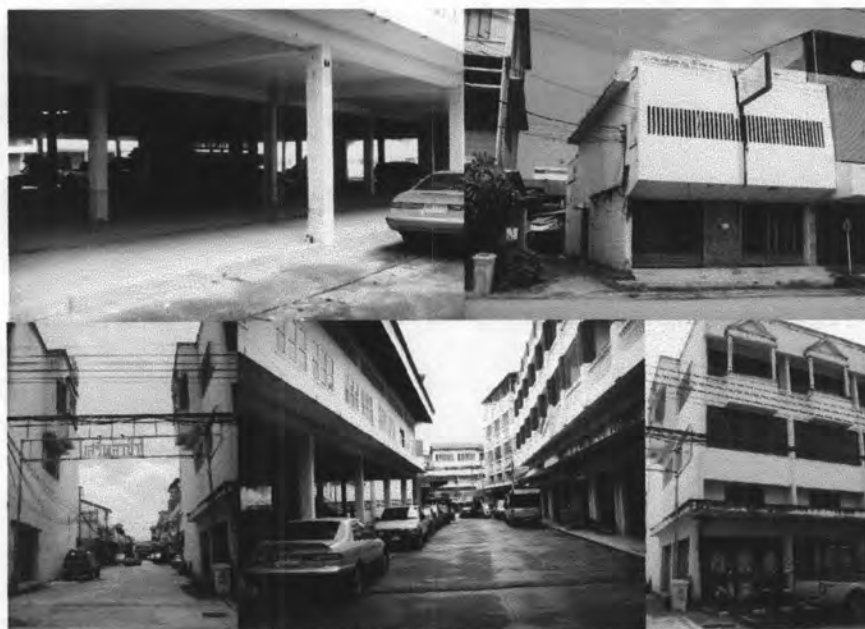
รูปที่ 4.46 อาคารใหม่ที่ไม่มีการใช้งานเป็นอาคารที่มีอายุการใช้งานไม่เกิน 50 ปี (ที่มา : จากการสำรวจของผู้วิจัย 2551)
