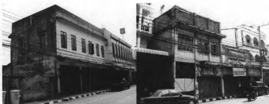
รูปที่ 4.44 อาคารเก่าที่ไม่มีการใช้งานเป็นอาคารที่มีอายุการใช้งานเกินกว่า 50 ปีขึ้นไป (ที่มา : จากการสำรวจของผู้วิจัย 2551)
