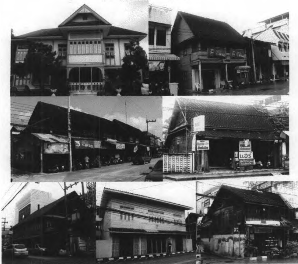
รูปที่ 4.48 สภาพอาคารไม้เก่าในบริเวณพื้นที่โครงการ (ที่มา : จากการสำรวจของผู้วิจัย 2551)
