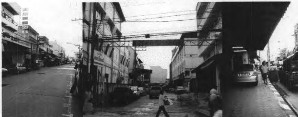
รูปที่ 4.31 สภาพการจอดรถยนต์ริมถนนในพื้นที่ย่านสี่แยกบ้านทุ่ง (ที่มา : จากการสำรวจของผู้วิจัย, 2551)
