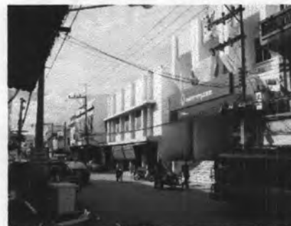
รูปที่ 4.15 สภาพถนนเจริญเมืองปัจจุบัน(2551)
