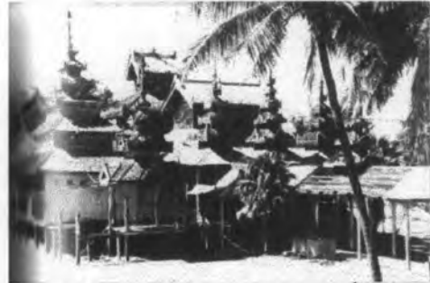
รูปที่ 4.6 วัดต้นธง หรือวัดจองใต้ หรือวัดเงี้ยว ปัจจุบัน ถูกรื้อและสร้างขึ้นใหม่ทั้งหมด
