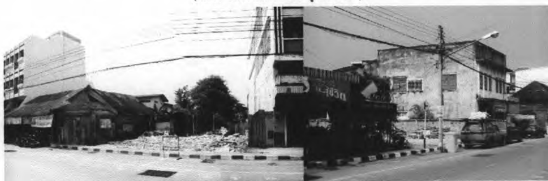
รูปที่ 4.43 สภาพพื้นที่ที่มีการรื้อถอนอาคารในพื้นที่โครงการ (ที่มา : จากการสำรวจของผู้วิจัย 2551)
