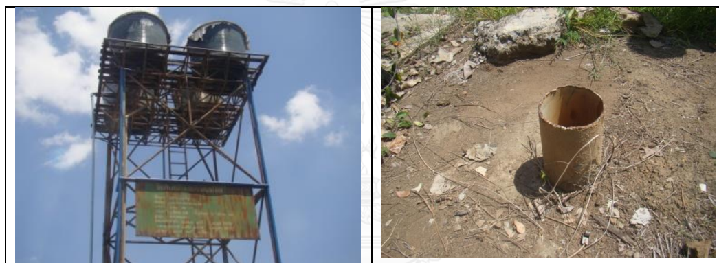
รูปที่ ภาคผนวก ข - 8 บ่อบาดาลสถานีที่ 8
