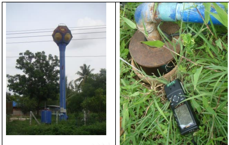
รูปที่ ภาคผนวก ข - 13 บ่อบาดาลสถานีที่ 13
