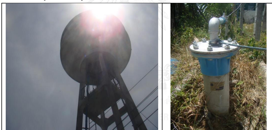
รูปที่ ภาคผนวก ข - 14 บ่อบาดาลสถานีที่ 14
