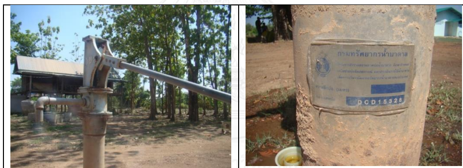
รูปที่ ภาคผนวก ข - 12 บ่อบาดาลสถานีที่ 12
