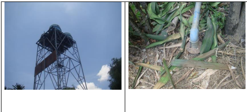
รูปที่ ภาคผนวก ข - 37 บ่อบาดาลสถานีที่ 37
