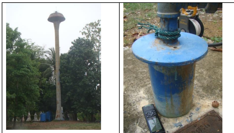
รูปที่ ภาคผนวก ข - 9 บ่อบาดาลสถานีที่ 9
