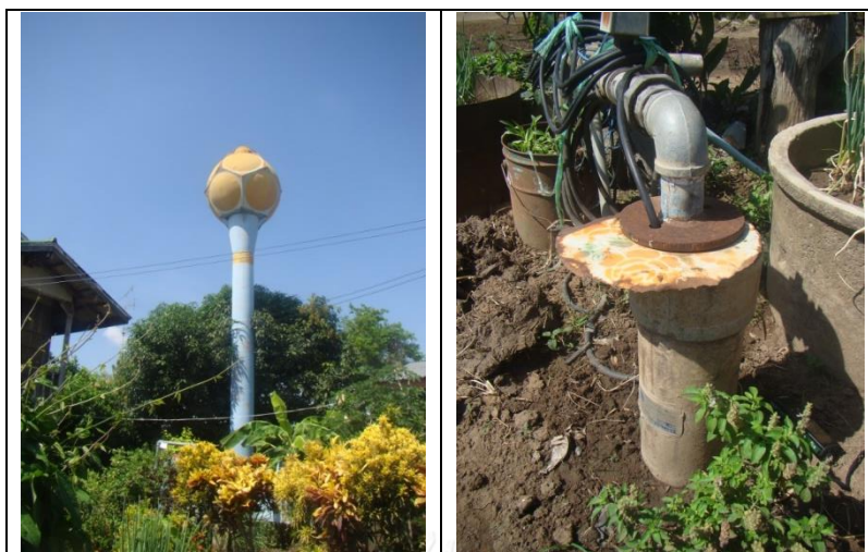
รูปที่ ภาคผนวก ข - 11 บ่อบาดาลสถานีที่ 11
