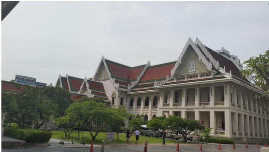
รูปที่ 3.2 อาคารเชิงคุณค่าหรืออาคารทางด้านสถาปัตยกรรมการก่อสร้าง
