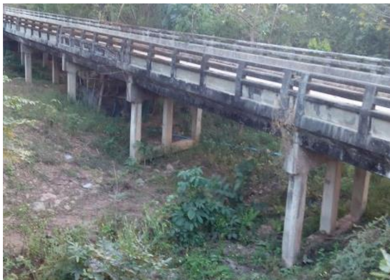
รูปที่ 1-1 สะพานแบบ Pile Bent (สะพานข้ามห้วยลึก อ.แม่สอด จ.ตาก 22 ก.พ. 2557)
