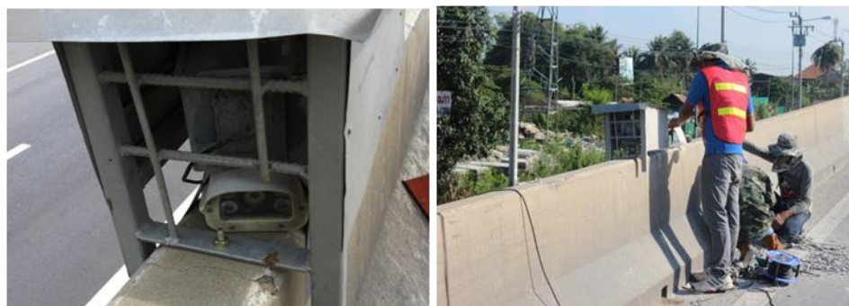
รูปที่ 3.18 ภาพการติดตั้งอุปกรณ์กล้องบันทึกภาพเคลื่อนไหว
