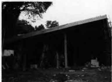
ห้องสมุดประชาชน (กำลังก่อสร้าง)
