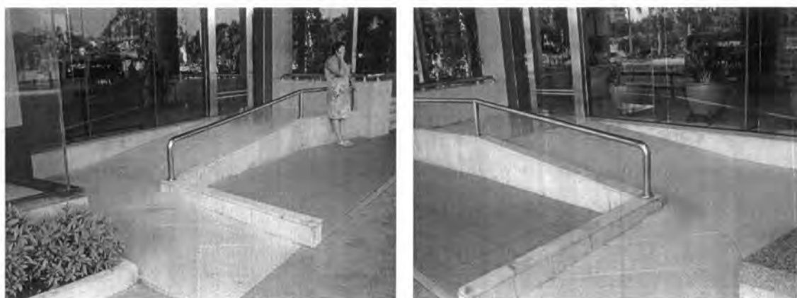
ภาพที่ 4.6 ทางลาดโครงการ ROYAL CLIFF BEACH RESORT
