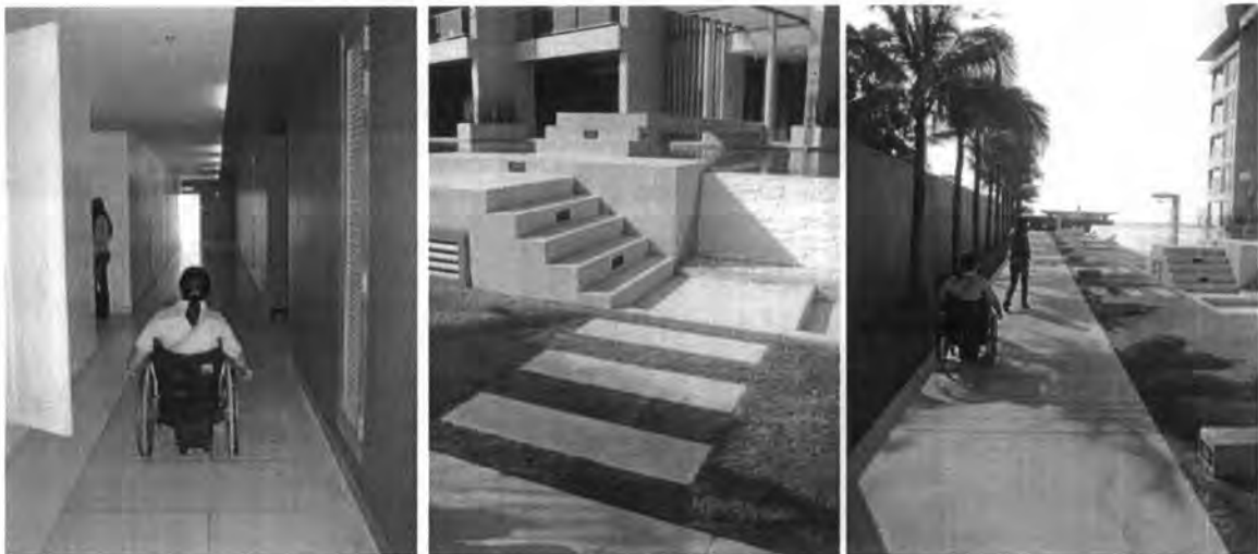
ภาพที่ 4.69 ทางเดินเชื่อมโครงการ ANAYA BEACHFRONT CONDOMINIUM
