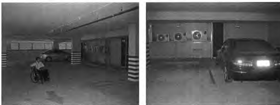
ภาพที่ 4.66 ที่จอดรถโครงการ ANAYA BEACHFRONT CONDOMINIUM
