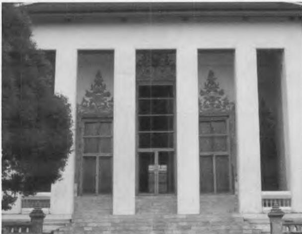
ภาพที่ 3.196 ลักษณะช่องประตูด้านสกัด ประตูกลางจะสูงกว่าประตู
