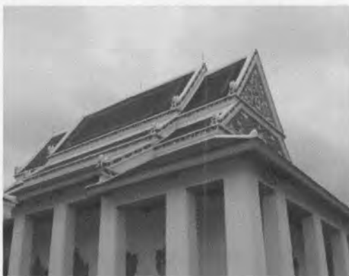
ภาพที่ 3.216 ลักษณะหลังคาพระอุโบสถ 3 ตับ 2 ชั้น
