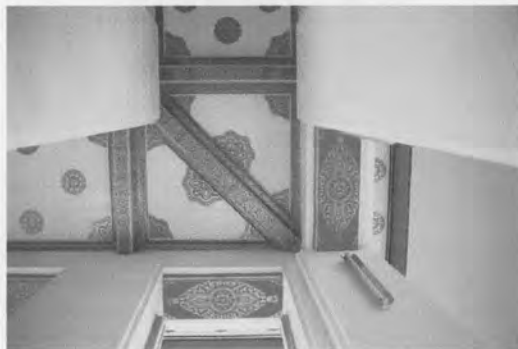
ภาพที่ 3.3 ฝ้าเพดานภายนอก ปิดทองจลุลายดาว พื้นลายสีแดงบนพื้นไม้สีขาวนวล
