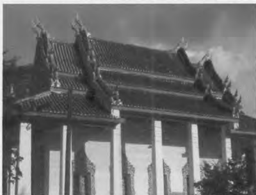
ภาพที่ 3.147 ลักษณะการแบ่งชั้นหลังคาและเครื่องล้าของพระวิหาร
