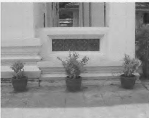
ภาพที่ 3.94 ฐานอาคารเป็นฐานสิงห์ ฐานส่วนระเบียงเป็นแบบไม่มีลูกแก้ว ฐานรับตัวห้องเป็นแบบมีลูกแก้ว
