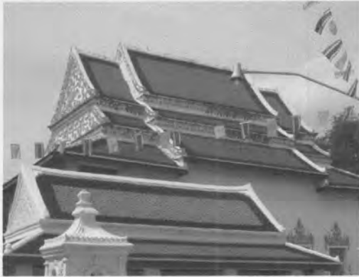
ภาพที่ 3.90 หลังคาการเปรียญ 2 ชั้น 3 ชั้น
