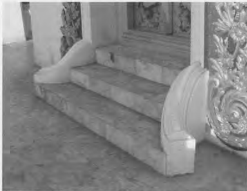
ภาพที่ 3.22 ผนังห้องด้านนอก ไม่มีฐานรับ บันไดหน้าช่องประตูมีพนักพลิงห์โค้งผายออก
