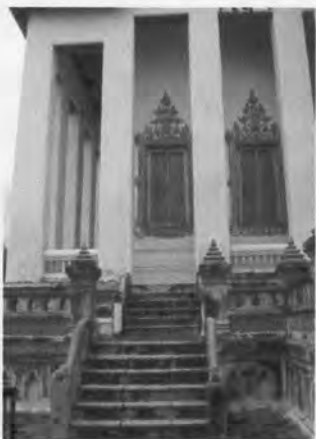
ภาพที่ 3.204 บันไดอาคารด้านยาว ตรงกับ บันไดของฐานประทักษิณชั้นบน
