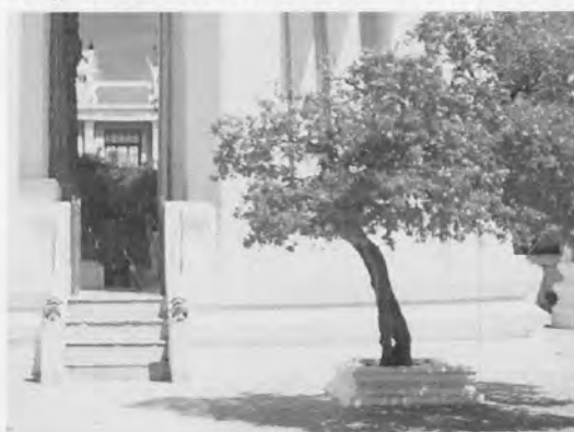
ภาพที่ 3.102 ฐานชั้นล่างเป็นฐานสิงห์ไม่มีลูกแก้ว ผนังพลสังห์ก่ออิฐถือปูน ปลายผนังประดับรูปสิงโตจีน
