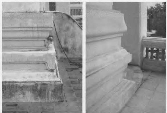
ภาพที่ 3.198-3.199 แสดงลักษณะบัวฐาน ฐานรับอาคาร และฐานรับห้องภายใน ตามลำดับ
