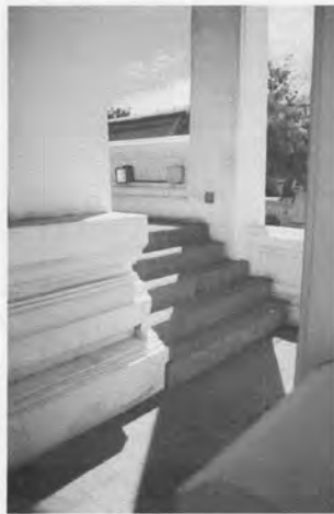
ภาพที่ 3.123 บันไดชั้นบนด้านหน้ากว้างเต็มช่วงเสาจนถึงเสาระเบียงด้านสกัด
