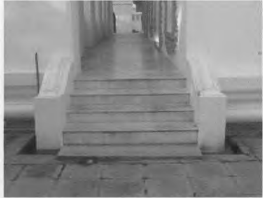
ภาพที่ 3.31 ฐานอาคารชั้นล่าง เป็นฐานสิงห์ไม่มีบัวลูกแก้ว พนักพลสิงห์ก่ออิฐฉาบปูนทาสีขาว ปั้นปั้นเป็นบัวหลังเจ็ดยศ
