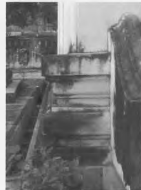
ภาพที่ 3.23 ฐานชั้นล่างเป็นฐานสิงห์ไม่มีลูกแก้ว บันได ชั้นล่างพนักพลิงห์ก่ออิฐฉาบปูน ปั้นสันเป็นบัวหลังเจียด
