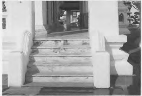
ภาพที่ 3.41 ฐานพระอุโบสถชั้นล่างเป็นฐานสิงห์ไม่มีลูกแก้ว ฐานชั้นบนเป็นฐานบัวคว่ำ บันไดชั้นล่างพนักพลสังห์ป็นันเป็นบัวแบบเทศคล้ายบัวหลังเจียด
