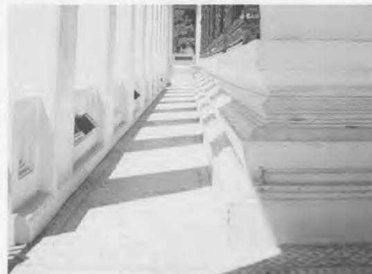
ภาพที่ 3.103 ฐานชั้นบนเป็นฐานสิงห์ลูกแก้ว ผนังกระเบื้องก่อตันไม้ประดับกระเบื้องปราง
