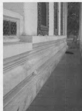
ภาพที่ 3.114 ฐานชั้นบนสูง เป็นฐานสิงห์ โดยจุดต่อระหว่างฐานเกลียงหน้าและฐาน ห้องแตกต่างกันด้วยการมีหรือไม่มีบัวลูกแก้ว
