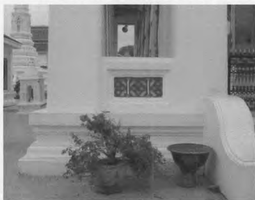
ภาพที่ 3.220 ลักษณะฐานรับอาคารและพนักพลสังห์พระอุโบสถ
