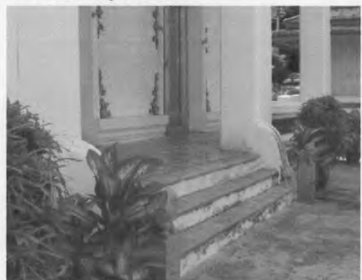
ภาพที่ 3.95 บันไดด้านหน้าและหลัง พนักพลสังข์ก่อโค้ง ปลายพนักประดับเสาหินยอดเสาเป็นรูปสิงโตจีน
