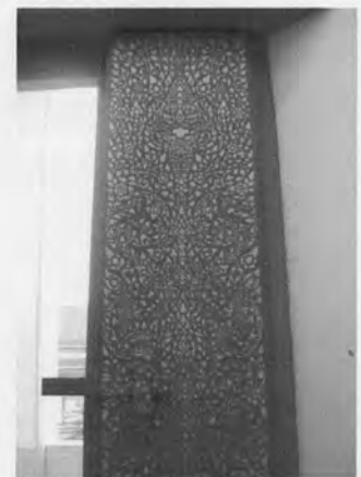
ภาพที่ 3.54 บานประตูหน้าต่างด้านหลัง เป็นลายช่อก้านขด จลูปิดทองบนพื้นสี เขียว ฝีมือการซ่อมในชั้นหลัง
