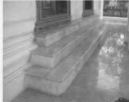
ภาพที่ 3.10 ฐานชั้นบนเป็นฐานสิงห์ไม่มีลูกแก้ว บันไดหน้าประตูยาวตลอดแนวช่องประตูทั้ง 2 ช่อง
