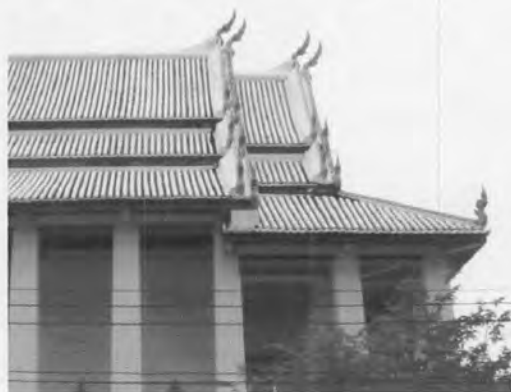
ภาพที่ 3.131 ลักษณะการแบ่งชั้นหลังคาพระอุโบสถ หลังคา 1 ชั้นจะมีเครื่องล้าของ 2 ชุดซ้อนกันอยู่
