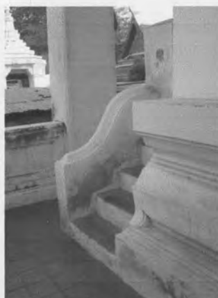
ภาพที่ 3.113 เกลียงยกชั้นด้านหน้าซึ่ง ถอยห่างออกจากแนวเสา ด้านสกัด มี บันไดแยกลงด้านข้างทั้ง 2 ฟาก
