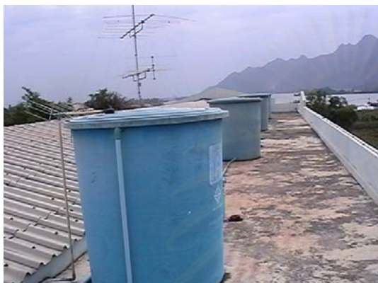
ภาพที่ 3.29 แสดงถังเก็บน้ำสำรองชั้นหลังคา
