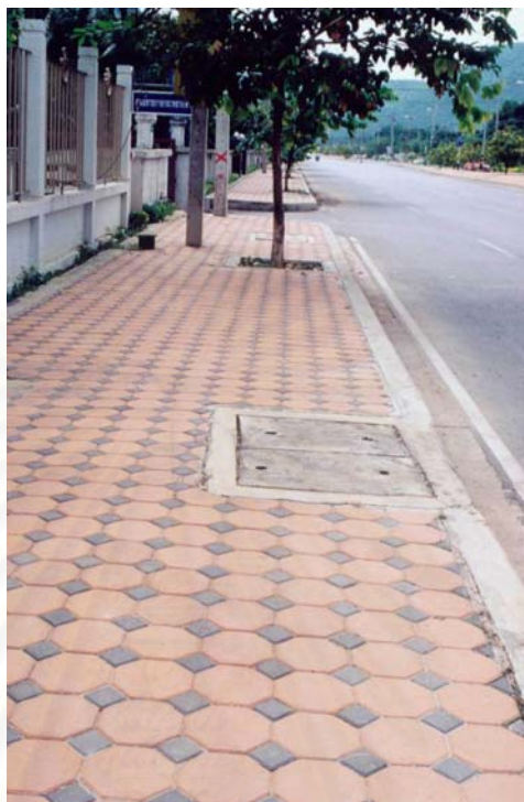
ภาพที่ 3.32 แสดงการยกระดับพื้นที่โครงการเท่าถนนหน้าโครงการ
