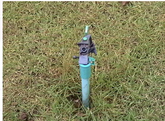
ภาพที่ 3.44 แสดงเครื่องฉีดน้ำอัตโนมัติ sprinkler
