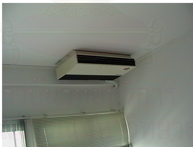
ภาพที่ 3.16 แสดงเครื่องปรับอากาศแบบแยกส่วน
