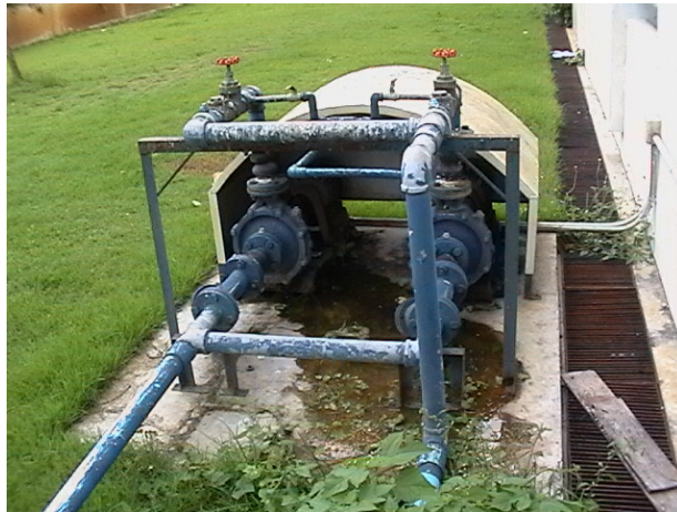
ภาพที่ 3.19 แสดงเครื่องปั้มน้ำอัตโนมัติ
