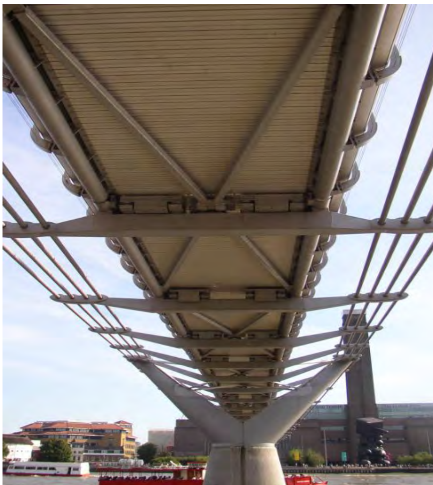
รูปที่ 1.9 แสดงตัวอย่างลักษณะของการติดตั้งตัวหน่วงชนิดของเหลวหนีตเข้ากับสะพาน
