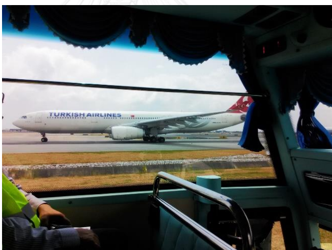
รูป 4.5 แสดงสถานที่ก่อสร้างที่อยู่ใกล้ลู่วิ่งของเครื่องบิน
