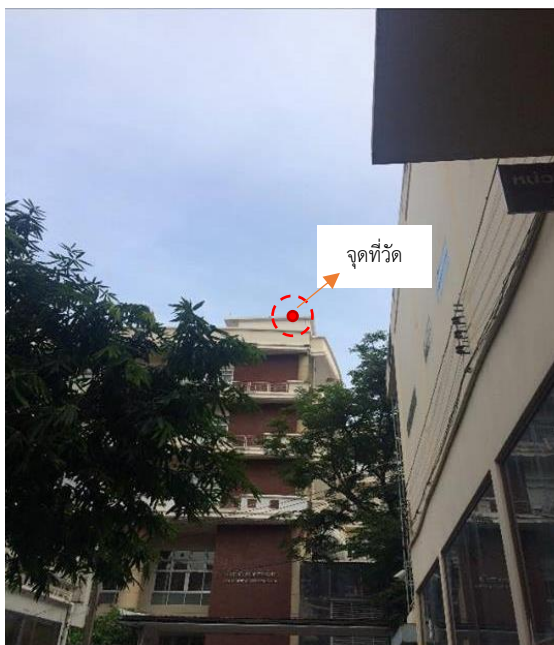
รูป 6.13 แสดงจุดที่ต้องการวัดบนอาคารปฏิบัติการวิศวกรรมโยธาและสิ่งแวดล้อม
