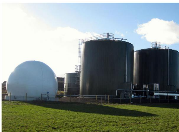
รูป 2.8 ถังปฏิกรณ์แบบตรึงเซลล์บนผิววัสดุตัวกลาง (กระทรวงพลังงาน, 2557)
