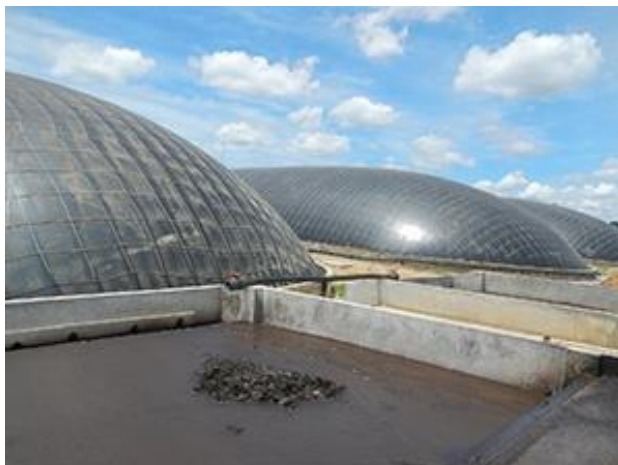
รูป 2.3 ระบบบ่อปิดผลิตก๊าซชีวภาพ (กระทรวงพลังงาน, 2557)
