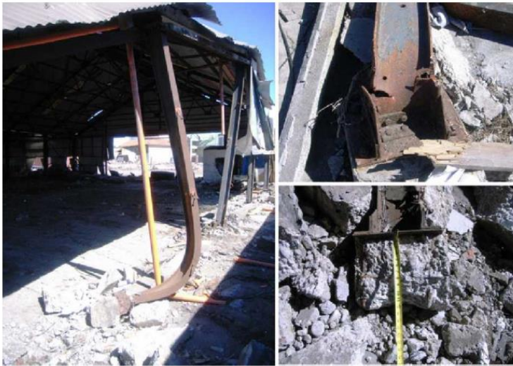
รูปที่ 2.39 การวิบัติของเสาอาคารที่บริเวณต่างๆ (Robertson and Chock, 2012)
