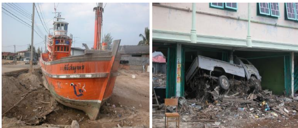
รูปที่ 1.1 ตัวอย่างของวัตถุที่ไหลมากับน้ำ (debris) จาก Indian Ocean Tsunami ในปี 2004 (FEMA P-646, 2012)
