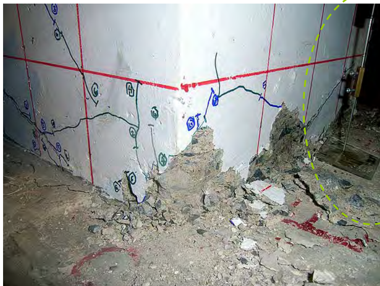
รูปที่ 5.15 การหลุดของแผ่นกระจกเนื่องจากการแตกของคอนกรีตบริเวณโคนเสา
