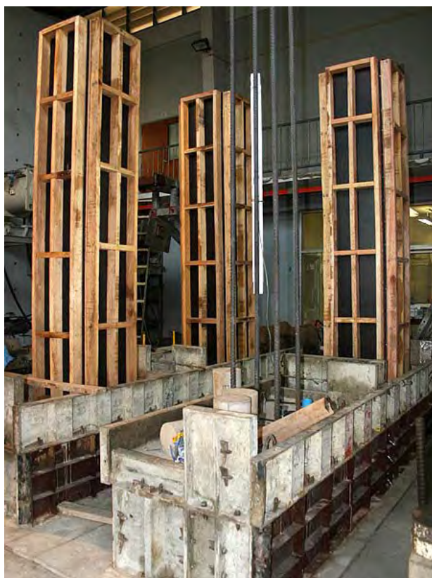
รูปที่ 4.14 การตั้งแบบเสา
