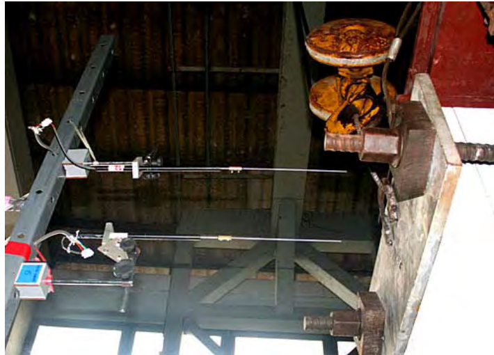
รูปที่ 4.19 การติดตั้งเครื่องวัดการเคลื่อนที่แบบไฟฟ้าที่ใช้วัดการเคลื่อนที่ของปลายเสา
