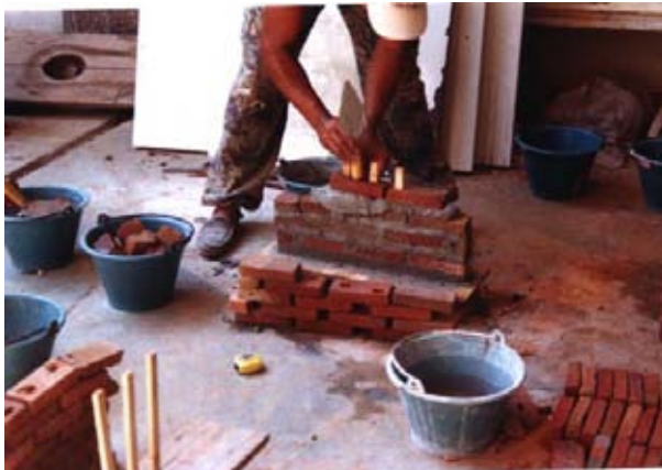
ภาพที่ 3.12 การก่ออิฐควรรทำในเวลาเดียวกัน
