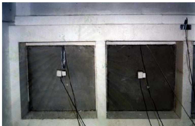
ภาพที่ 3.18 การติดตั้งผนังก่ออิฐ 1 ชั้นและผนังคอนกรีตมวลเบา
