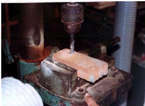
ภาพที่ 3.8 การเจาะอิฐเพื่อเตรียมช่องสำหรับติดตั้ง Sensor
