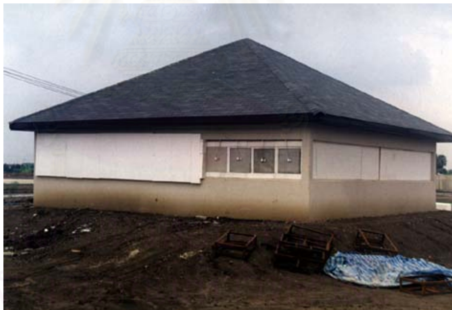
ภาพที่ 3.21 ด้านนอกวัสดุที่ติดตั้งเสร็จ
