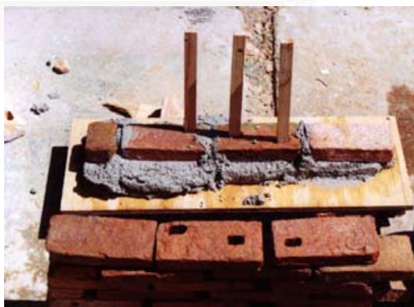
ภาพที่ 3.11 การก่ออิฐตามแนวที่กำหนด
