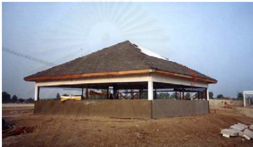
ภาพที่ 3.6 อาคารทดลอง
