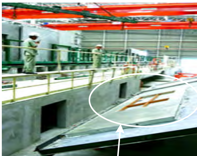
ขึ้นส่วนคอนกรีตเสริมเหล็กสำเร็จรูป
