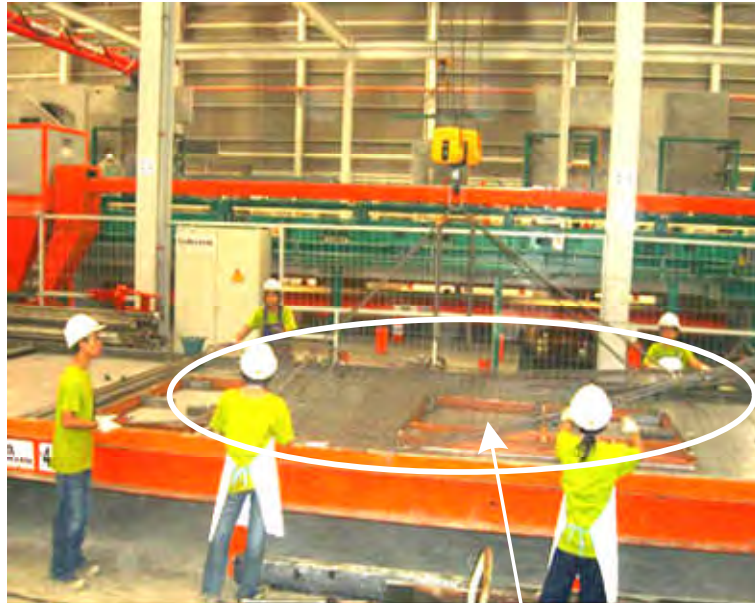
วางโครงเหล็กเสริมความแข็งแรง
