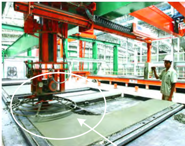
ตัดผิวหน้าคอนกรีต
