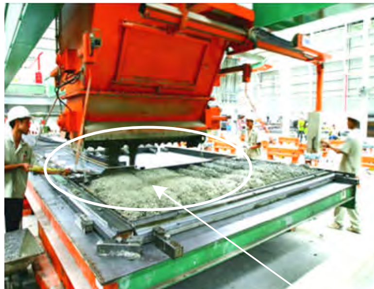
เทคอนกรีต
