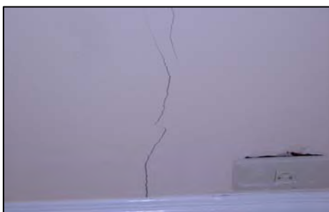
ภาพที่ 5.4 บ้านทรุด และ อุปกรณ์เต้าเสียบไม่เรียบร้อย
