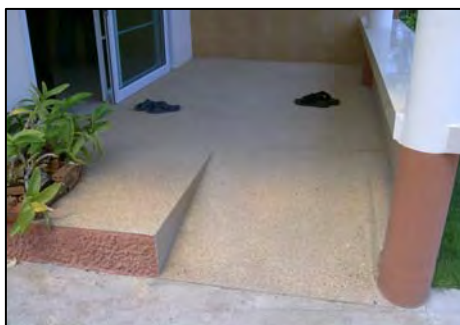
ภาพที่ 4.39-4.41 พื้นบ้านเรียบเป็นระดับเดียว พื้นที่ทางลาดหน้าบ้านพักอาศัย
