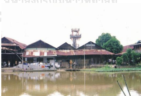
ภาพที่ 40 ชุมชนตลาดเก่าห้องริมแม่น้ำท่าจีนก่อนมีโครงการสร้างเขื่อนฯ
