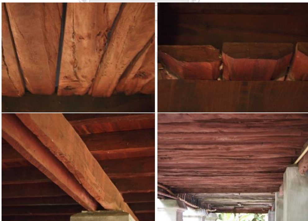
ภาพ 20 ภาพโครงสร้างไม้คุ่มเจ้ายอดเรือน จ.ลำพูน แสดงลักษณะไม้ที่ถูกแปรรูปด้วยการใช้เครื่องมือขวานถาก
