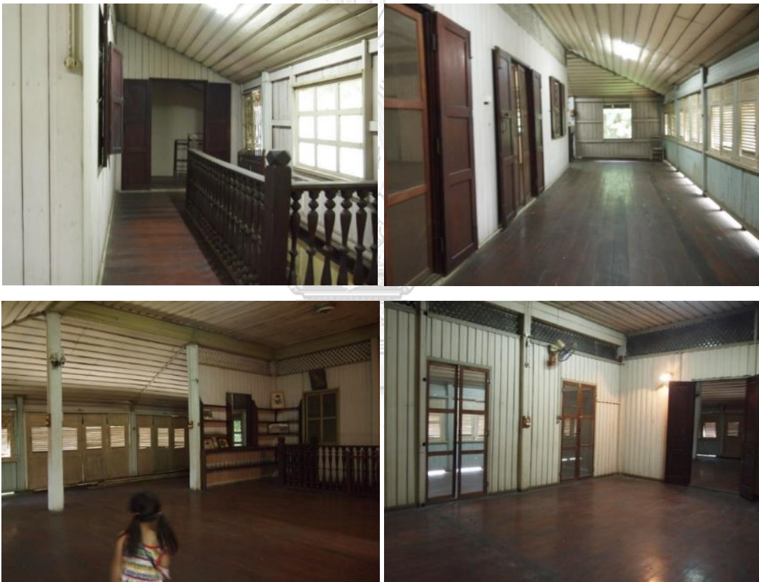
ภาพ 52 สภาพภายในอาคาร ชั้นบน
